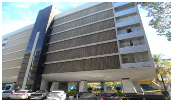
VISTA - FRENTE - SQS 316 BLOCO B(2)
