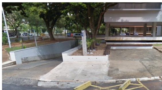
ENTRADA DA GARAGEM - SQS 203 BLOCO I
