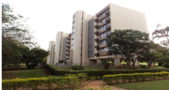
VISTA- LATERAL - SQN 112 BLOCO D
