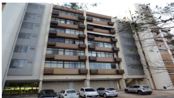
VISTA - FRENTE - SQN 112 BLOCO D
