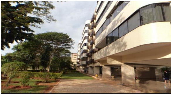
VISTA - FUNDOS -SQN 112 BLOCO D
