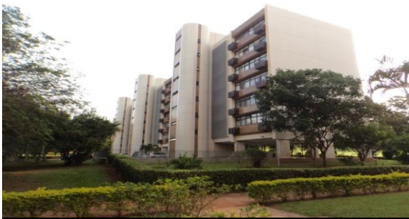
VISTA- LATERAL - SQN 112 BLOCO D
