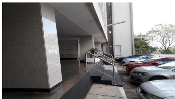
VISTA - LATERAL - SQN 106 BLOCO I
