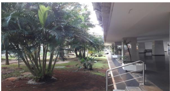
VISTA - LATERAL - SQN 106 BLOCO I (2)
