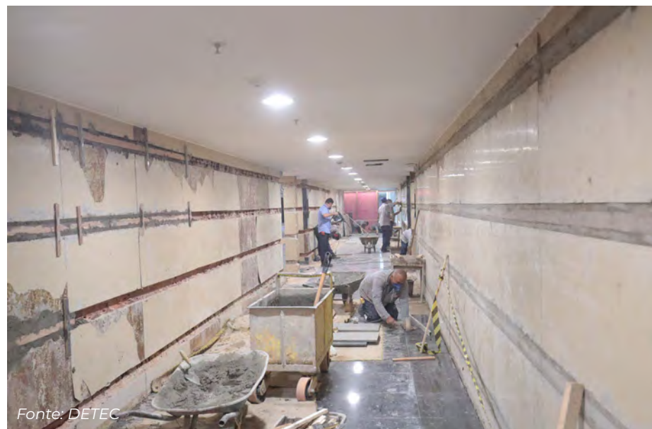
Figura 24 - Preparação para colocação de novo revestimento
