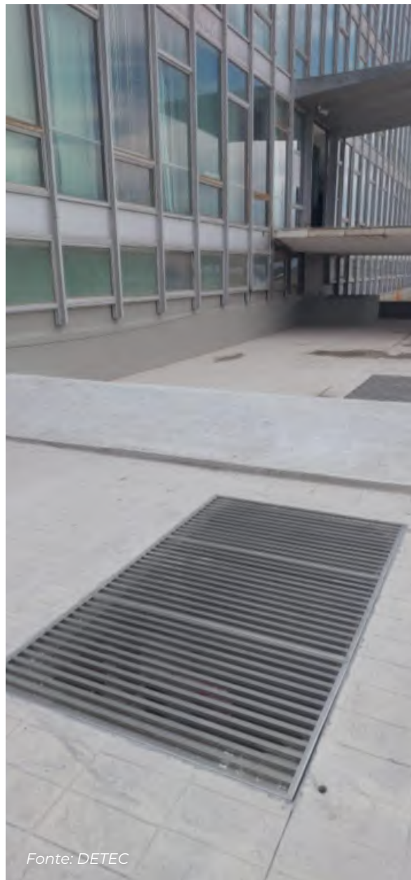
Figura 20 - Obras de adequação do espelho d'água
