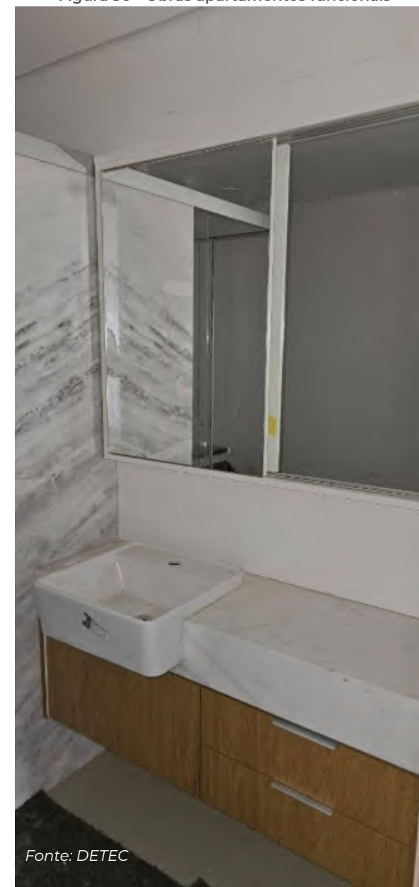
Figura 30 - Obras apartamentos funcionais
