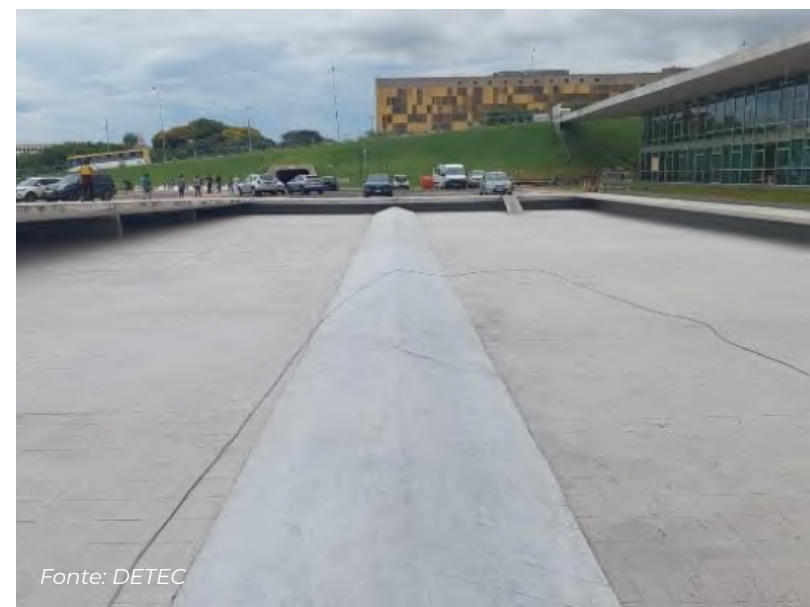
Figura 22 - Conclusão do sistema de impermeabilização e estrutura
