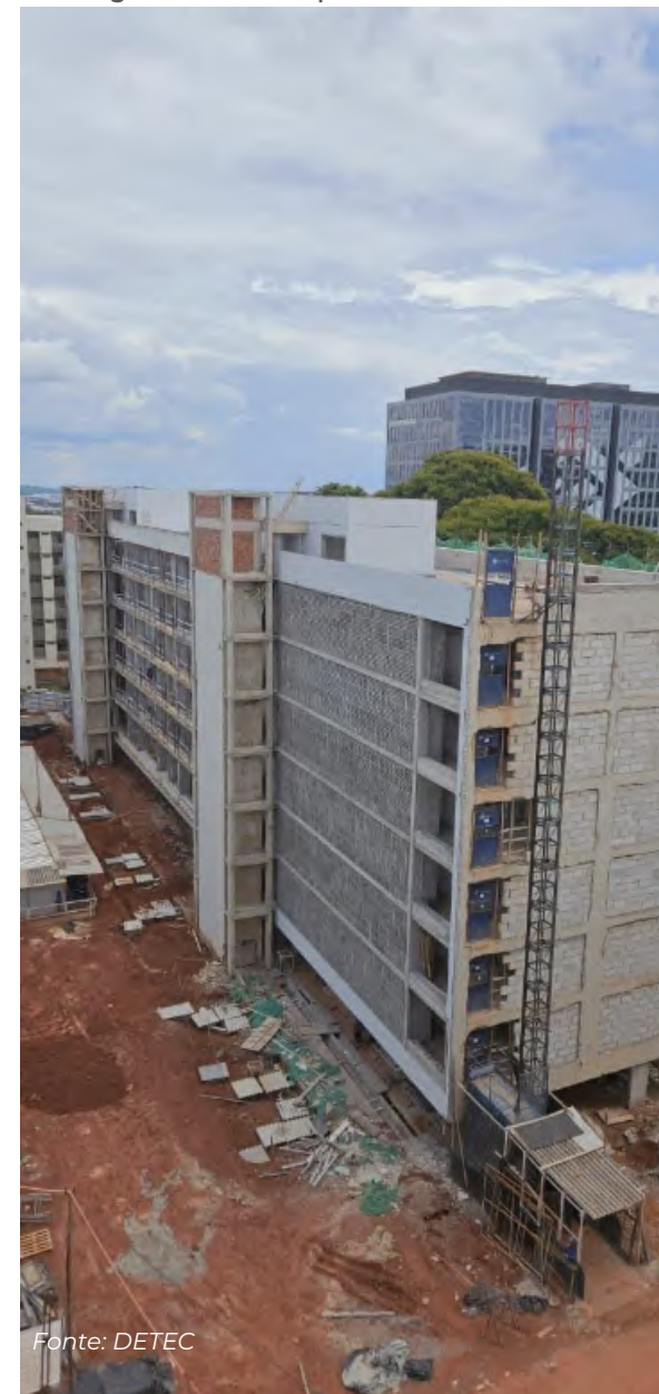
Figura 27 - Obras apartamentos funcionais
