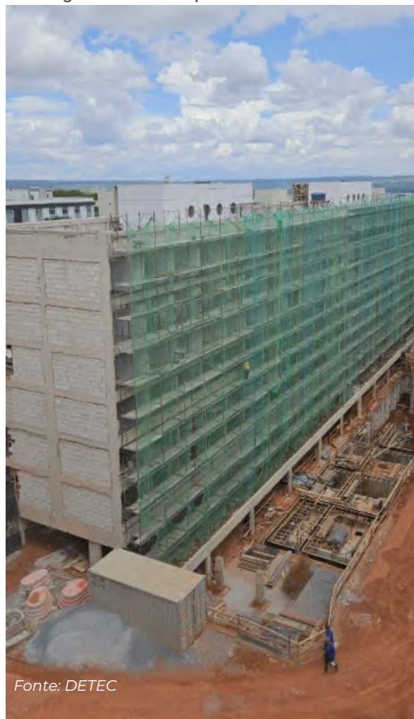
Figura 26 - Obras apartamentos funcionais
