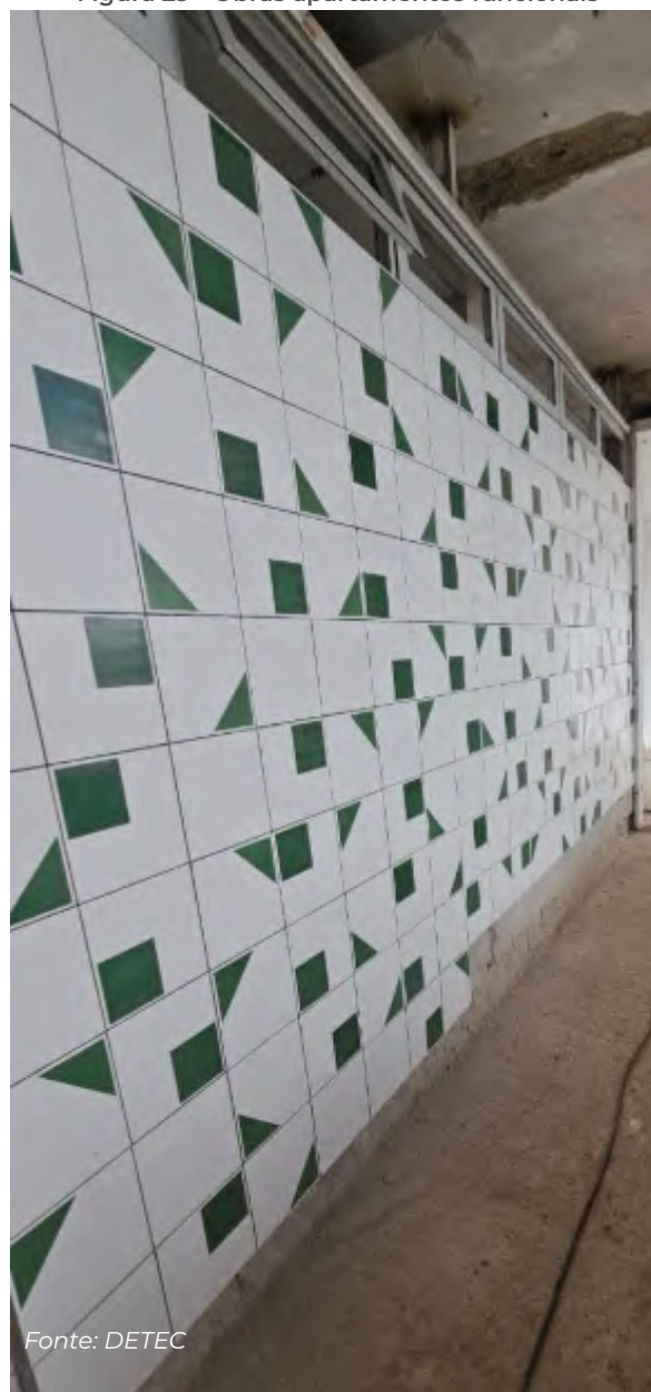
Figura 29 - Obras apartamentos funcionais
