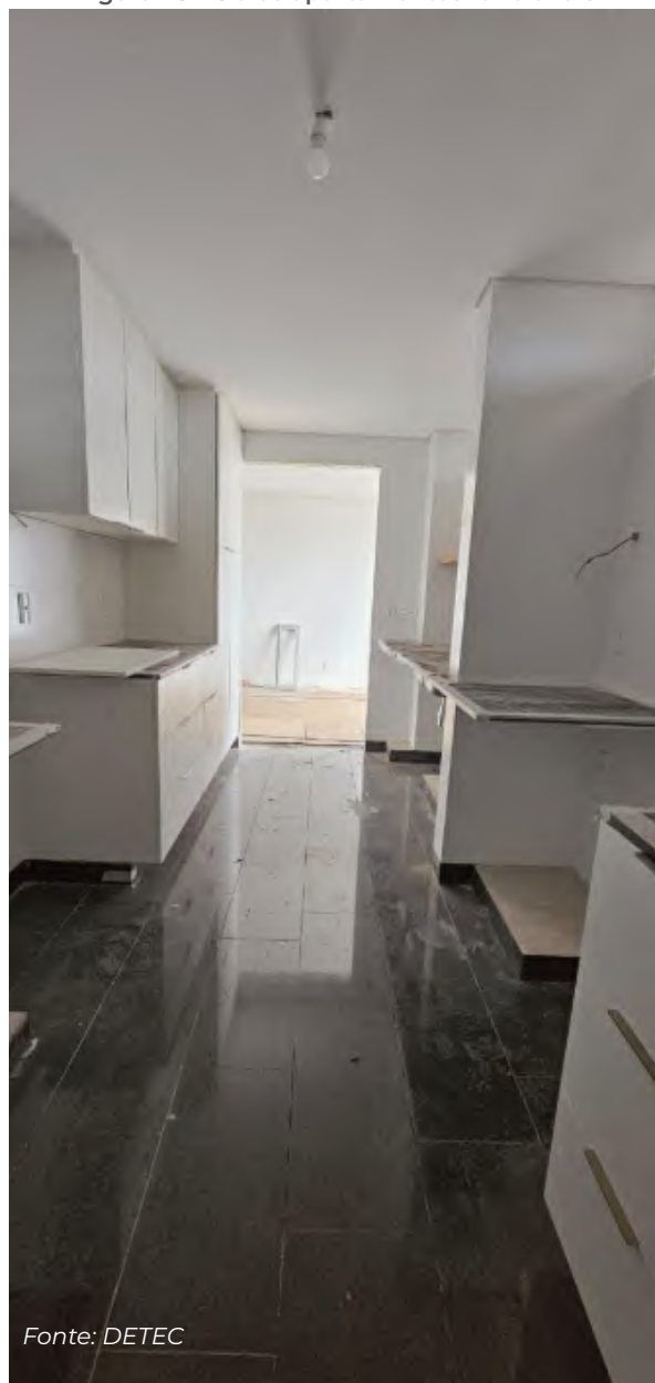
Figura 28 - Obras apartamentos funcionais
