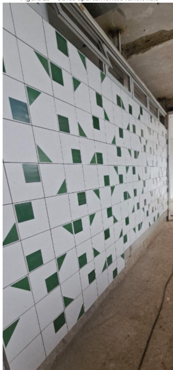
Figura 29 - Obras apartamentos funcionais
