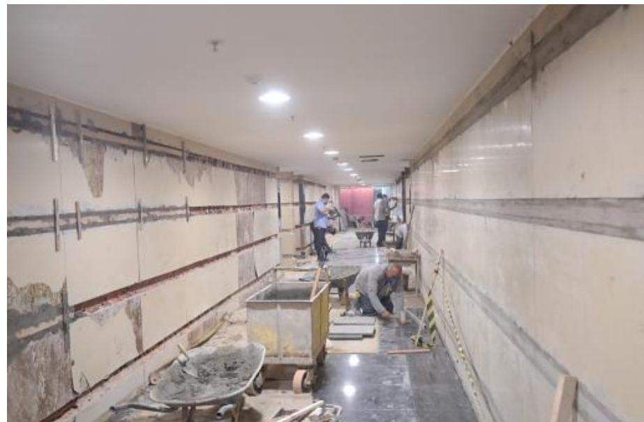
Figura 24 - Preparação para colocação de novo revestimento
