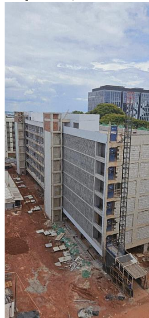
Figura 27 - Obras apartamentos funcionais
