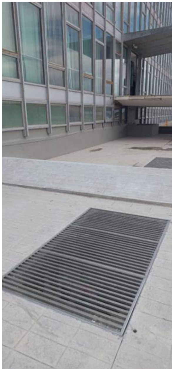
Figura 20 - Obras de adequação do espelho d'água
