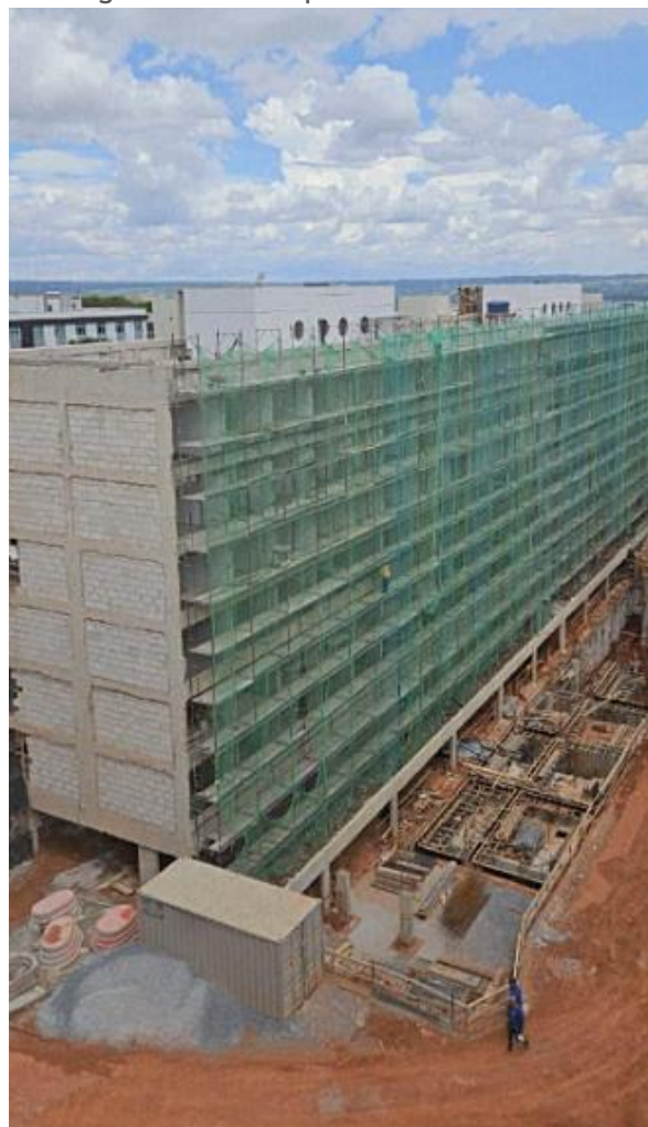
Figura 26 - Obras apartamentos funcionais
