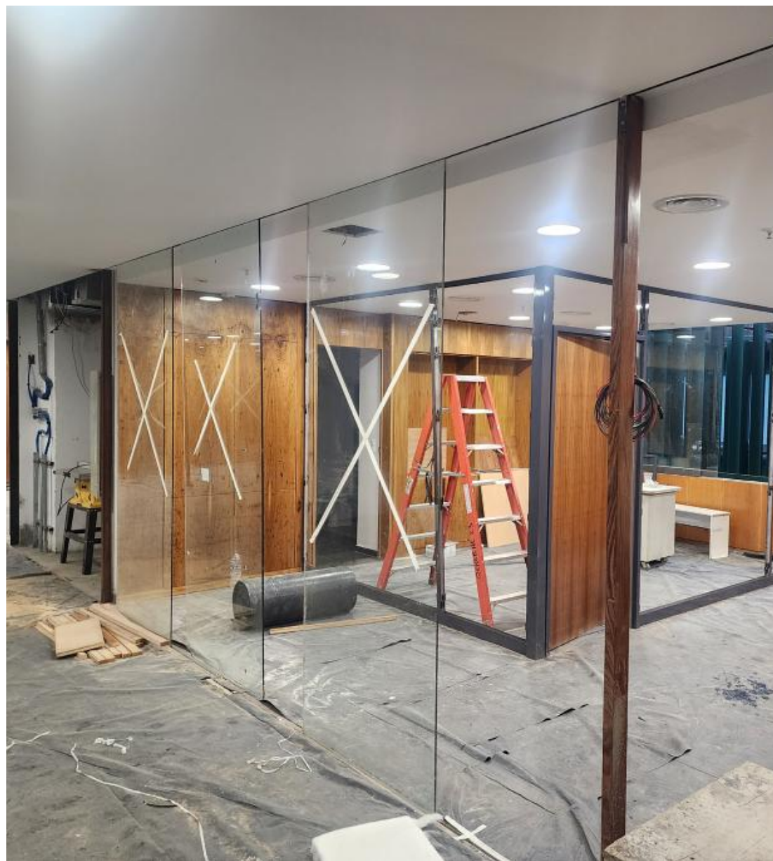
Figura 19 - Obras em gabinetes parlamentares do térreo do Anexo III
