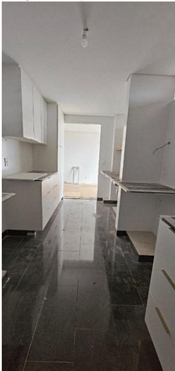
Figura 28 - Obras apartamentos funcionais
