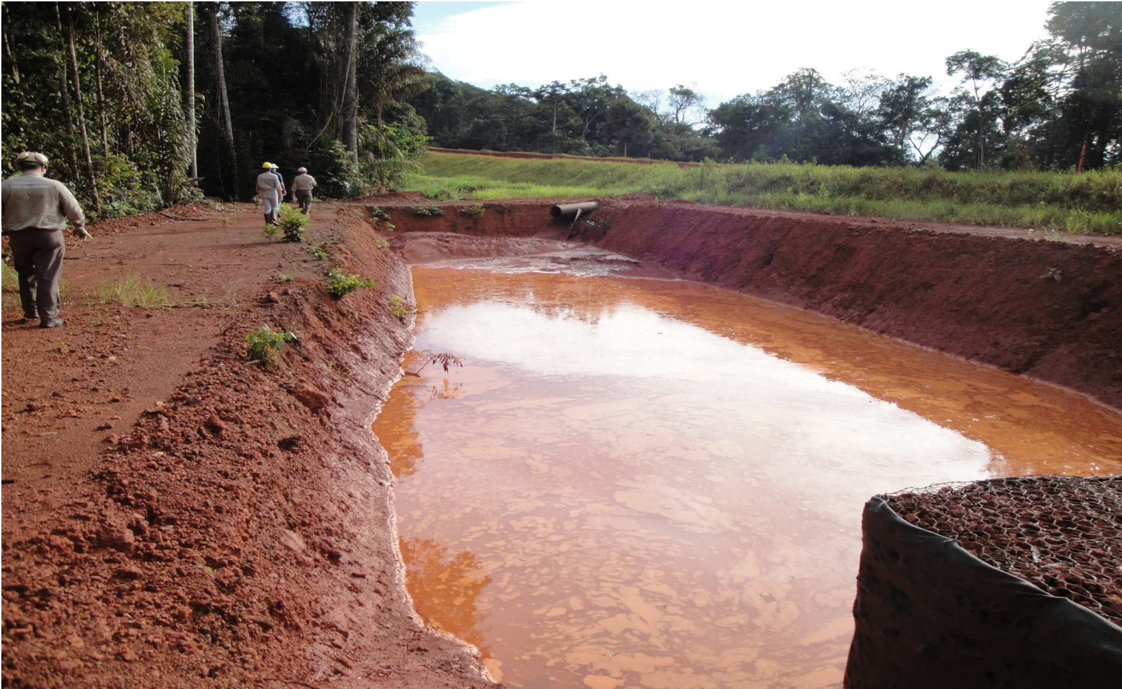
Sistema de drenagem – caixas de sedimentação
