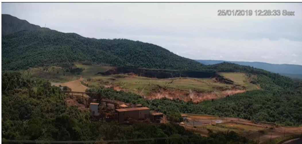
Figura 4 – Sequência do rompimento da barragem B1 (cont.)
