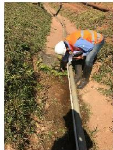
Foto 14 – Surgência de água sob dispositivo de drenagem no contato do maciço com a ombreira esquerda.
