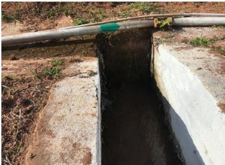
Foto 17 – Solapamento no início da descida d'água em escada, na berma da EL. 872 m.
