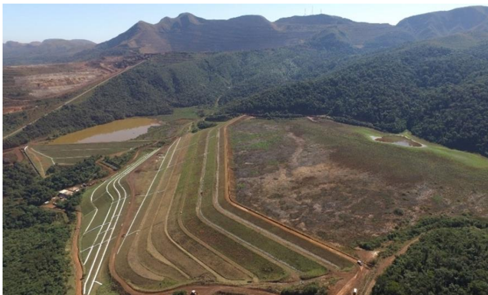
Figura 1 – Vista aérea da barragem B1
