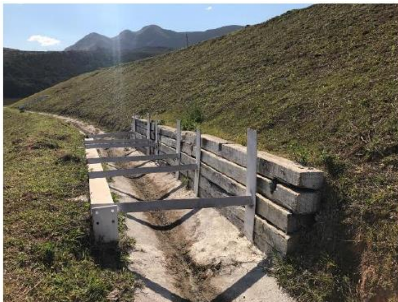
Foto 19– Escoramento realizado em um talude da barragem que apresentou ruptura local EL. 895m.
