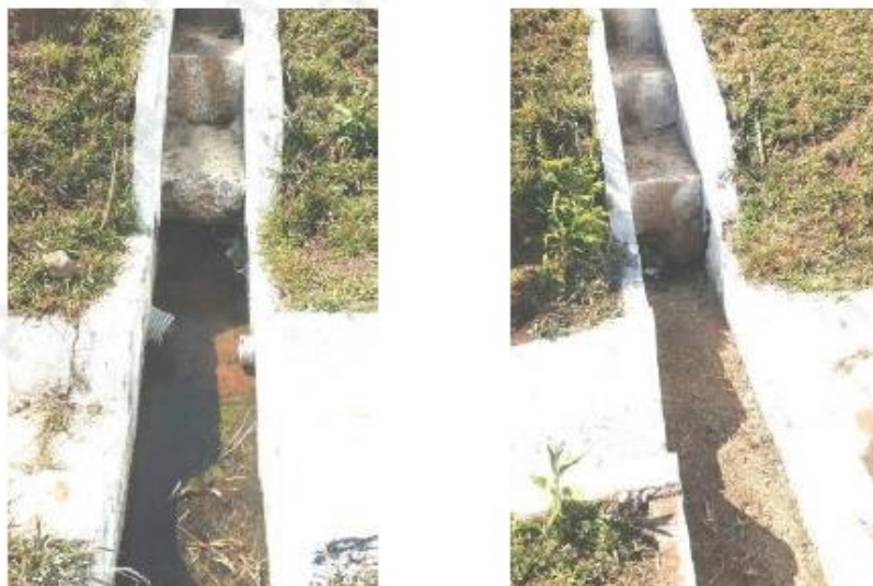
Foto 10 – Solapamento da base (contato entre a descida e o canal) nas trincheiras indicadas existentes na berma na EL. 899 m).
