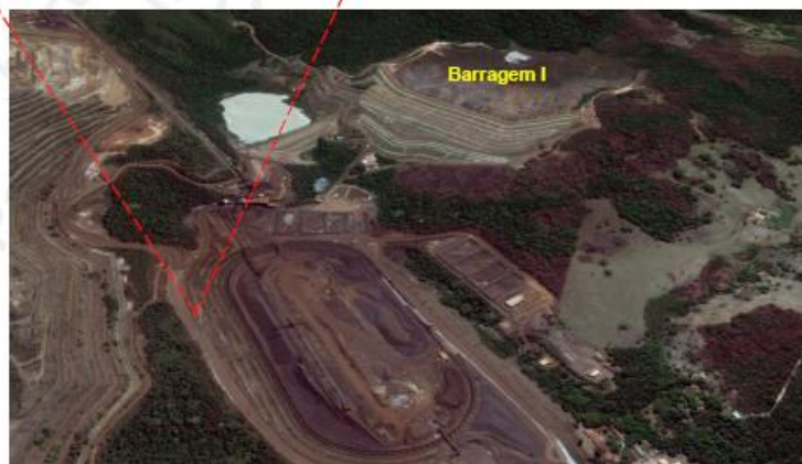
Local de instalação do radar.
