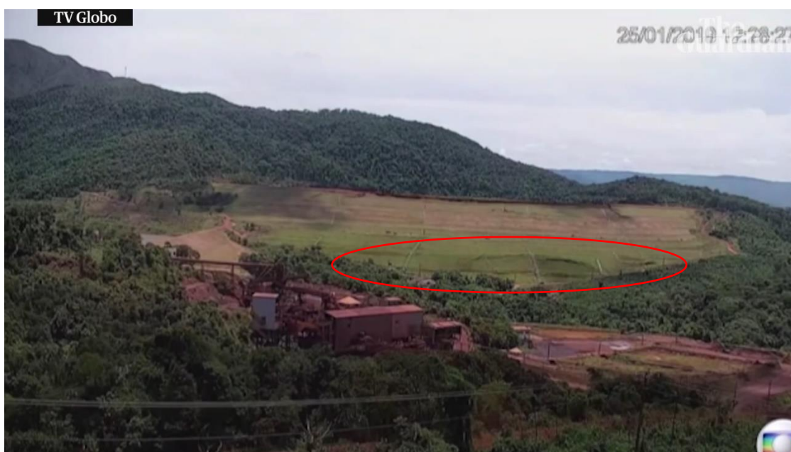
Figuras 27 – Imagem do rompimento da barragem B1
