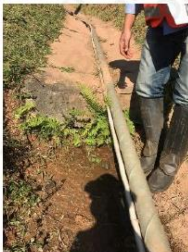
Foto 14 – Surgência de água sob dispositivo de drenagem no contato do maciço com a ombreira esquerda.
