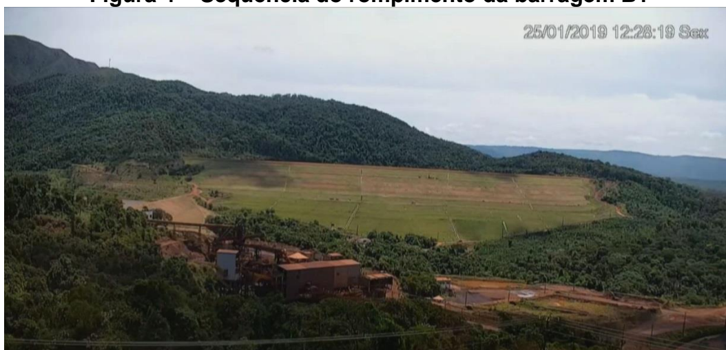
Figura 4 – Sequência do rompimento da barragem B1
