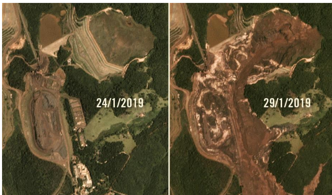
Figura 40 – Imagem aérea de parte da área diretamente afetada pelo rompimento da barragem B1
