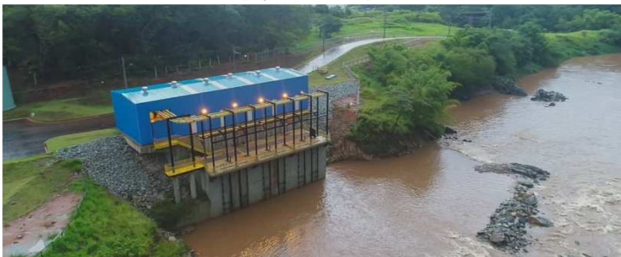
Foto 28 – Vista da Captação do Rio Paraopeba, concluída em 2015
