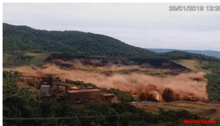
Figura 10: Momento do rompimento da barragem B1.
