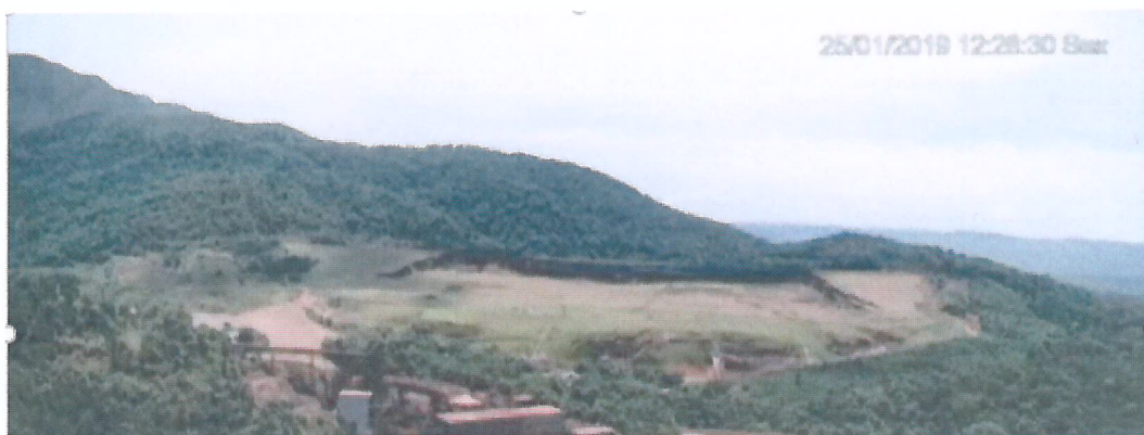
Figura 8 – Imagem capturada do momento de ruptura da Barragem I, mostrando o rompimento no terço inferior do maciço.
