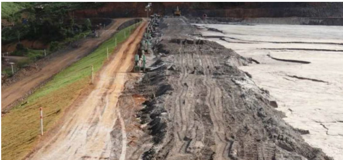
Figura 8 – Primeiro alteamento da barragem do Fundão 17 .
