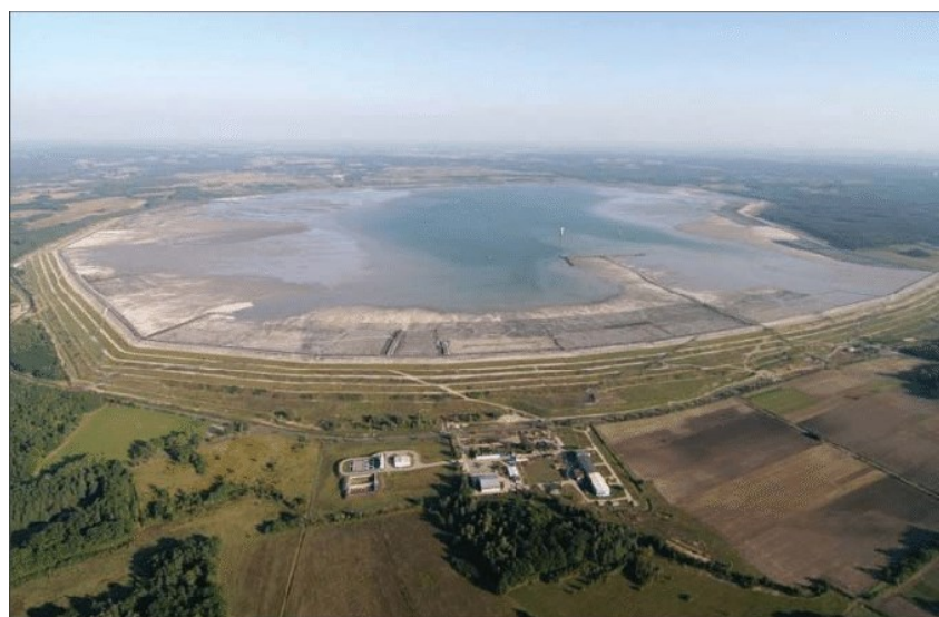
Figura 7 – Formação de lagoa de decantação no interior de barragem de rejeitos de mineração 15 .
