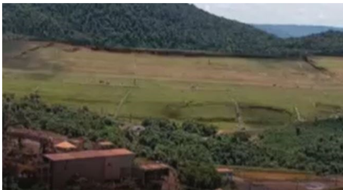
Figura 4 – Imagem capturada a partir do filme do rompimento da Barragem I, mostrando as fraturas na ombreira esquerda e na parte inferior.
