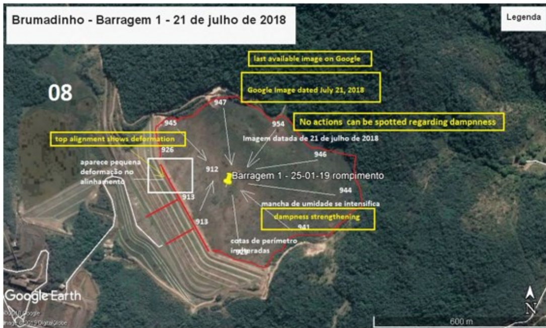
Figura 5 – Imagem da Barragem I obtida pelo Google Earth em 21 de julho de 2018.
