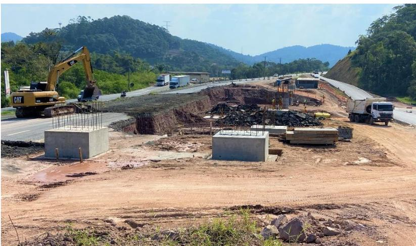
**DESCRIÇÃO:** Duplicação da rodovia em pavimento flexível, construção de vias laterais, restauração da pista existente, 2 novas pontes e 13 viadutos, além da restauração de 2 pontes
