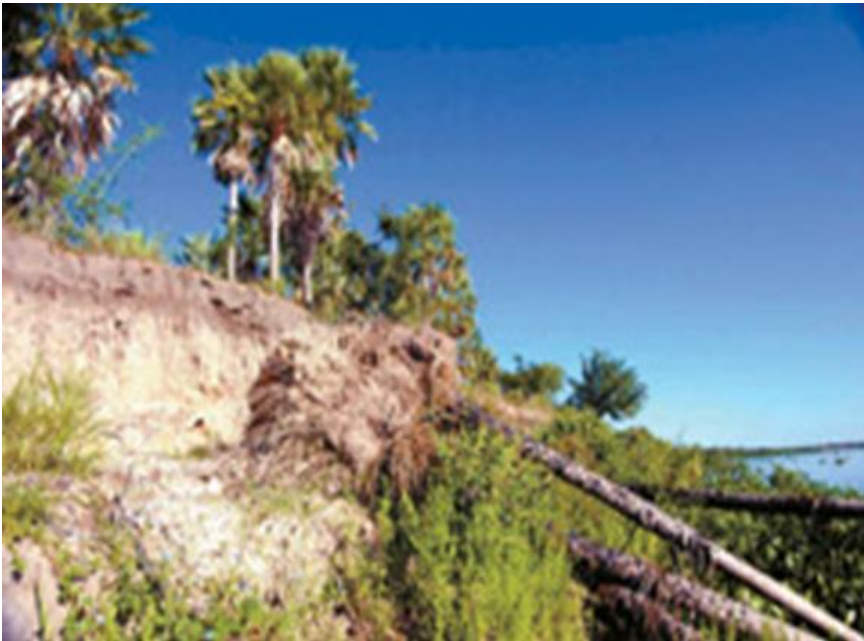
Solapamento (desmoronamento) das margens do rio Paraguai na região do Nabileque (MS) devido a ação do choque de ondas provocadas pela passagem de grandes embarcações, na década de 2000. Foto – mídia digital.
