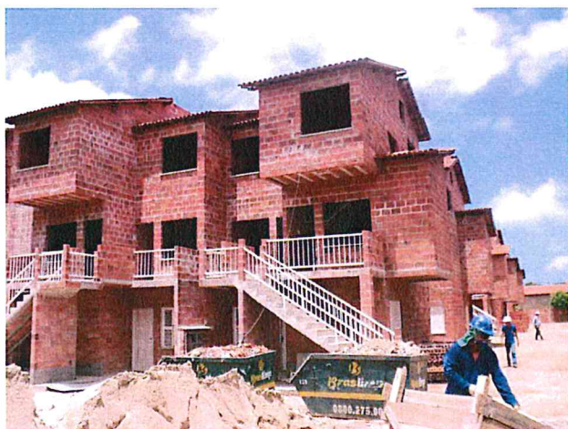
Vila do Mar II durante a execução da obra
