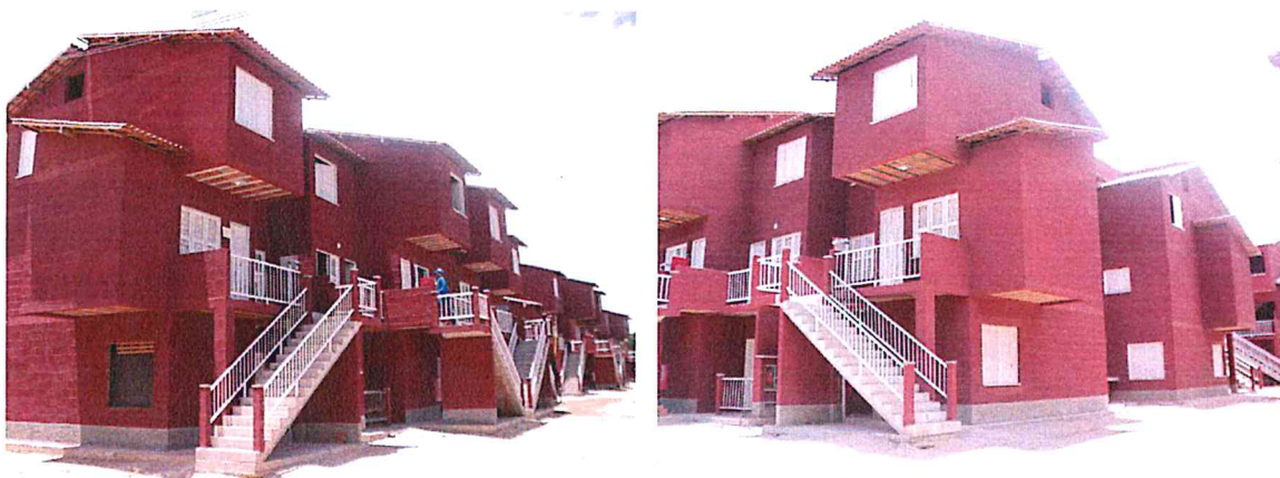
Vila do Mar III, primeira quadra , antes da ordem de retirada dos funcionários da Celi. Obra praticamente concluída.
