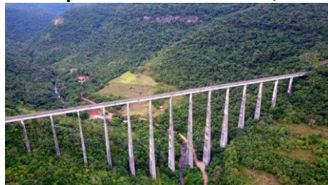
VIADUTO 13 Ferrovia do trigo Vespasiano Corrêa/RS
