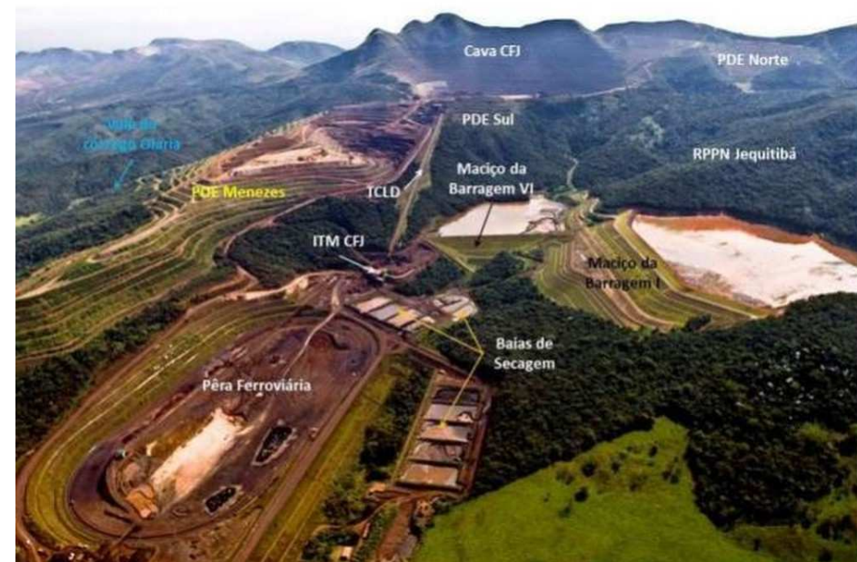
Figura 1. Mina de Córrego do Feijão. Fonte: G1.
