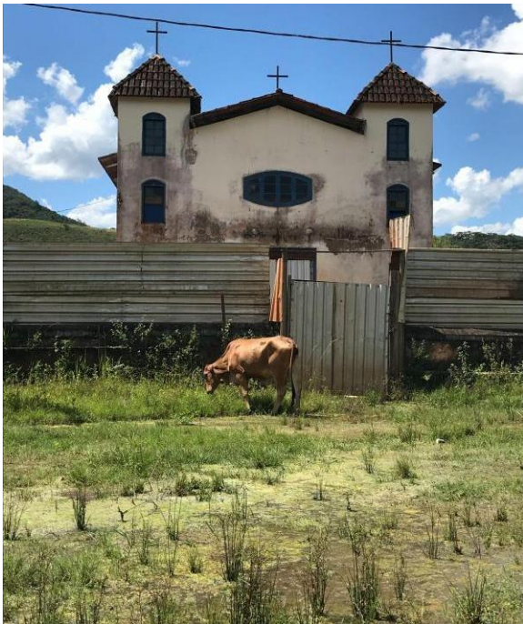
Alagamento no adro da Igreja de Santo Antônio. Foto: Flora Passos/Cáritas-MG, em 09/03/22.
