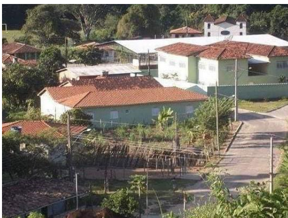
Arruamento principal asfaltado e em boas condições, antes do rompimento da barragem. Foto: Acervo CABF.
