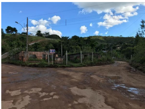
Ponto de alagamento próximo ao entroncamento entre as ruas Furquim (à dir.) e Gualaxo (à esq.). Foto: Flora Passos/Cáritas-MG, em 24/03/22.
