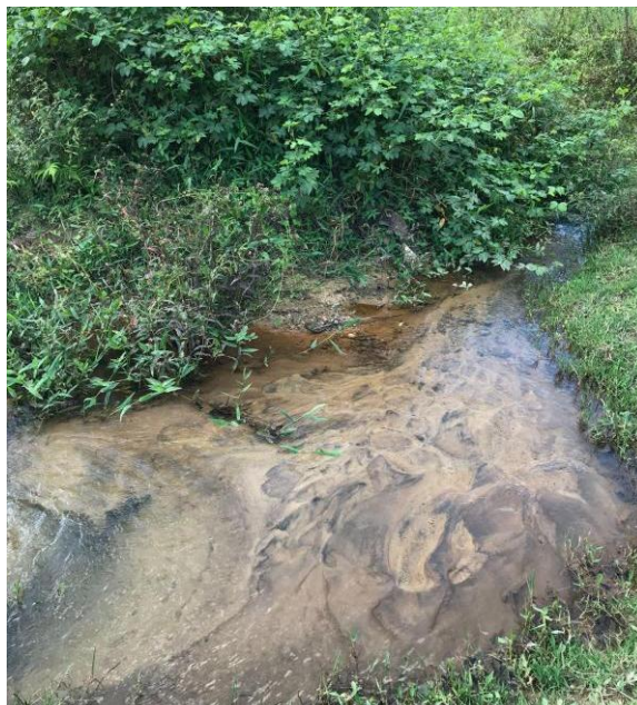
Assoreamento próximo ao entroncamento. Foto: Flora Passos/Cáritas-MG, em 24/03/22.
