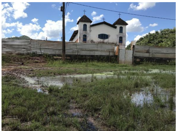
Entorno da Igreja alagada impedindo o uso do acesso principal e causando danos ao bem tombado. Foto: Flora Passos/Cáritas-MG, em 09/03/22.
