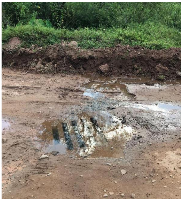
Destaque para a boca de lobo transbordando água. Foto: Flora Passos/Cáritas-MG, em 24/03/22.
