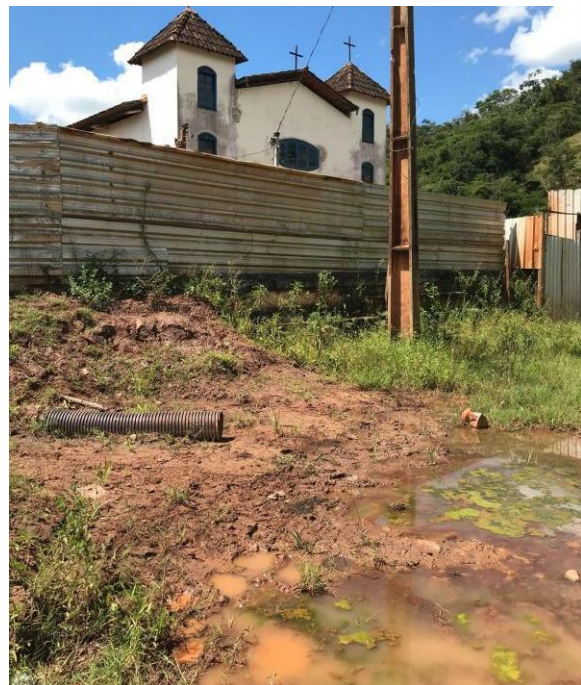
Tubo Corrugado PEAD direcionando a captação de água do interior da Igreja para acesso frontal. Foto: Lucas Marra/Cáritas-MG, em 09/03/22.
