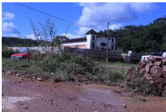
Condições precárias das vias e margens. Foto: Wan Campos/Cáritas-MG, em 24/03/22.
