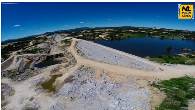
Ensecadeira e fundações da Barragem
