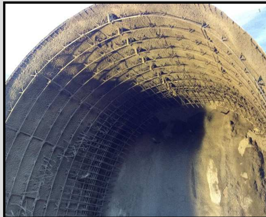
12 – BOA VISTA – Desemboque – Execução de Túnel - Cambotas
