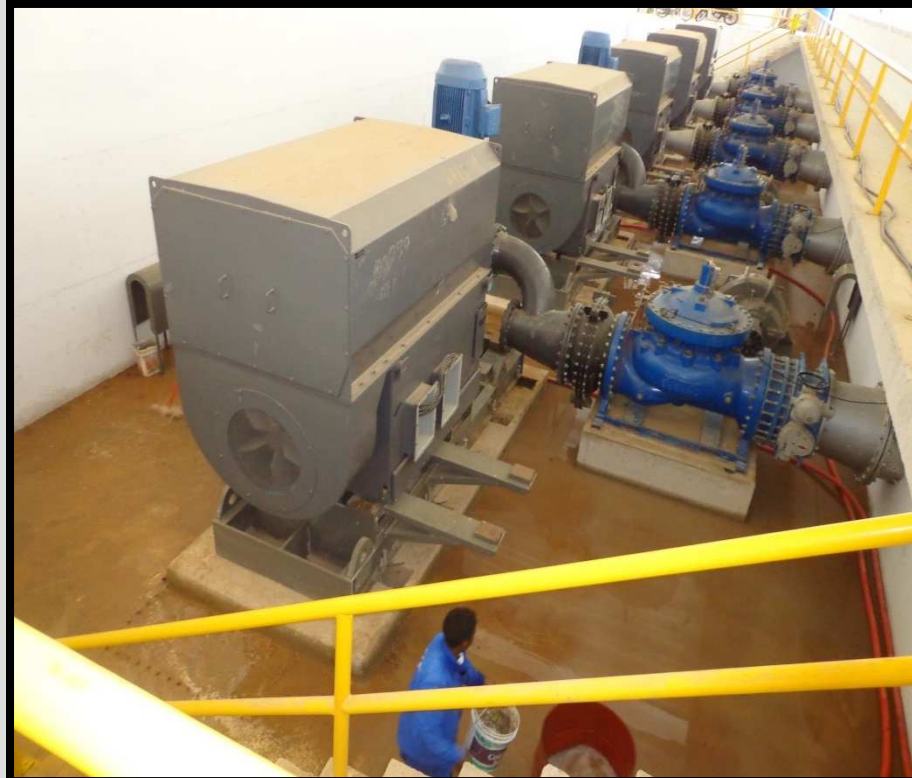
02 – Eletrobombas da Estação Elevatória – E.E 02.
