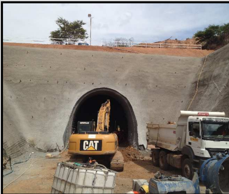
11 – BOA VISTA – Desemboque – Execução de Túnel
