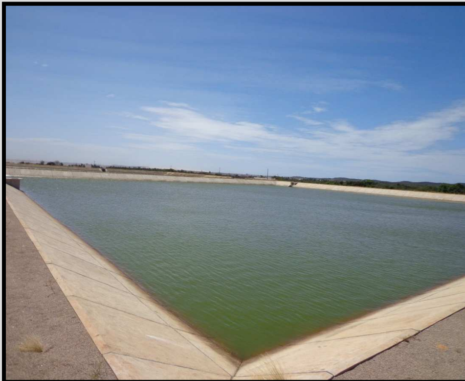
01 – Reservatório Apoiado com capacidade de 15.000 m 3 (Estação Elevatória – E.E 02).
