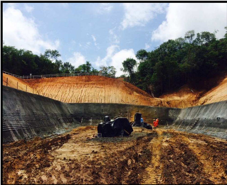
09 – CABACEIRA – Desemboque – Aplicação de concreto projetado e tela
