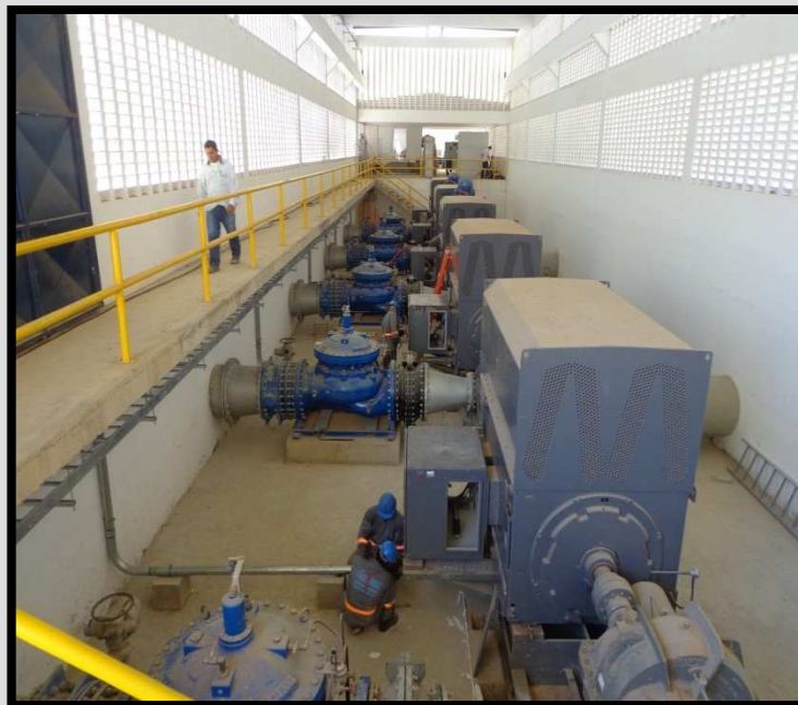
02 – Eletrobombas da Estação Elevatória – E.E 01.
