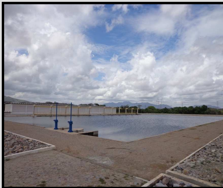
01 – Reservatório Apoiado com capacidade de 15.000 m 3 (Estação Elevatória – E.E 01).
