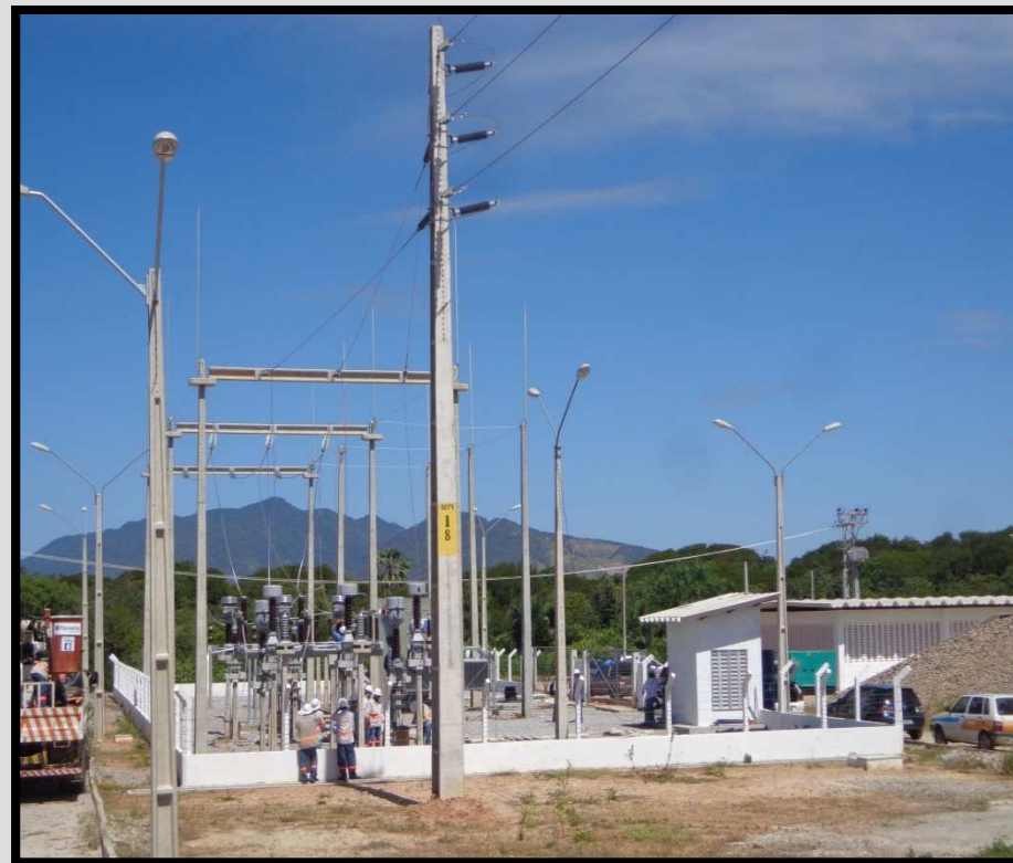
04 – Subestação em 69 KVA da Estação Elevatória – E.E 01.
