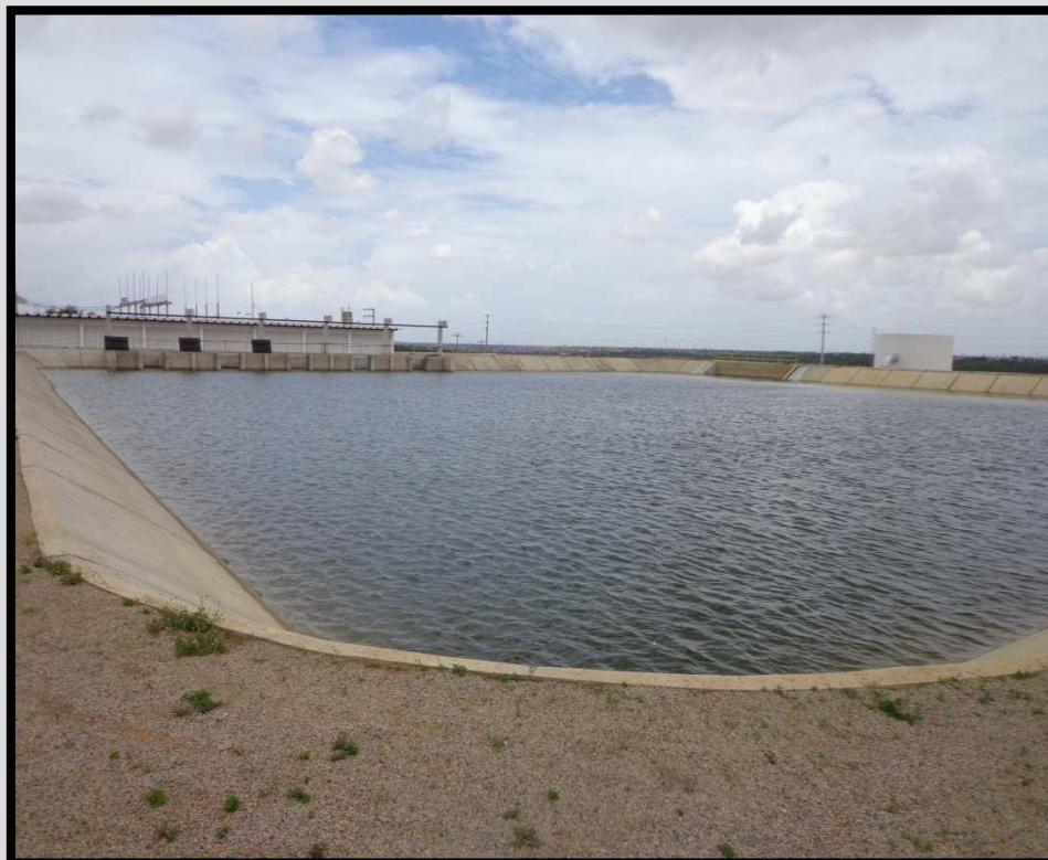
03 – Outra vista do Reservatório Apoiado com capacidade de 15.000 m 3 (Estação Elevatória – E.E 02)
