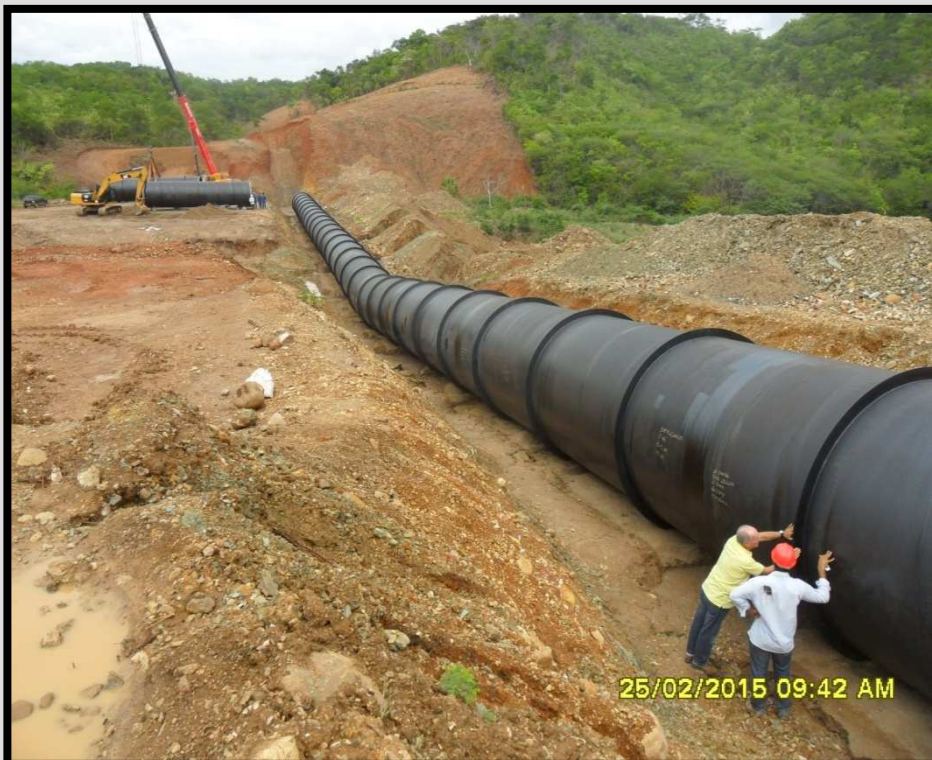
03 – Teste da qualidade do revestimento sendo executado por Engº Hidromecânico do Consórcio Supervisor Engesoft/IBI, em tubulação DN 2.800mm do Sifão Caldeirão km 138+870,00 a 139+200,00
