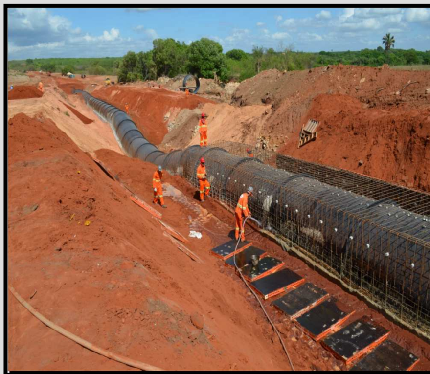
06 – Envelopamento da tubulação do Sifão Barreiro - km 69+100
