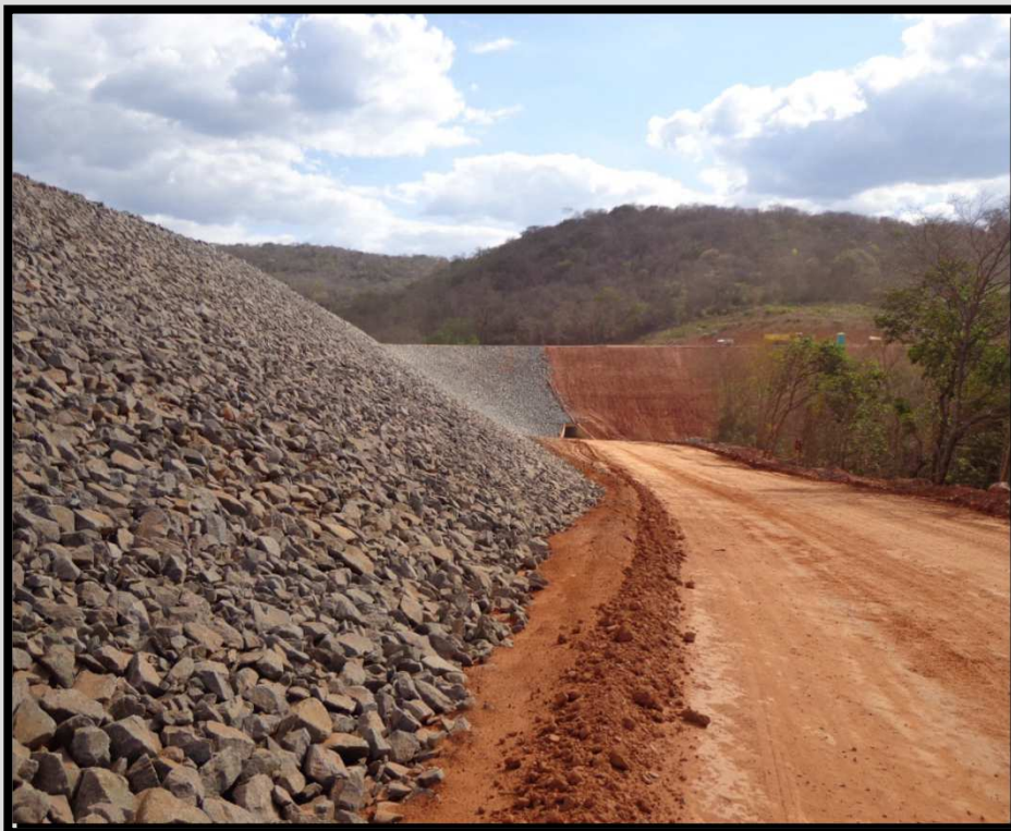
09 – Proteção de Talude de Aterro - Canal 15 - km 61+300
