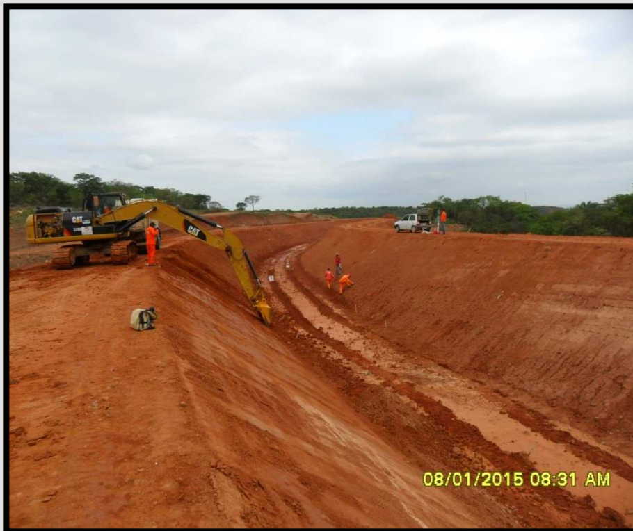
03 – Execução de seção hidráulica de canal km 83+293 a 85+293. 7,35% executado
