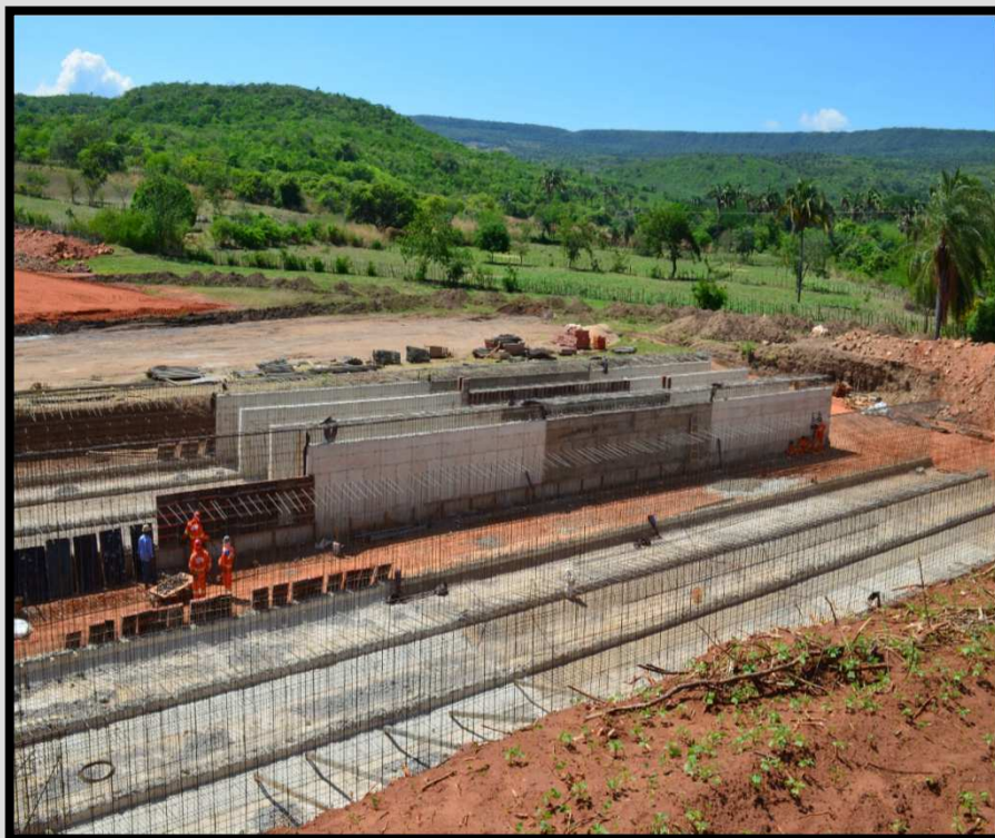
07 – Execução de corpo de 2x BTCC 3,00x3,00m - km 70+828
