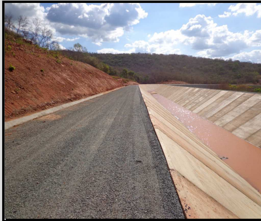
10 – Revestimento das Bermas - Canal 15 - km 60+800
