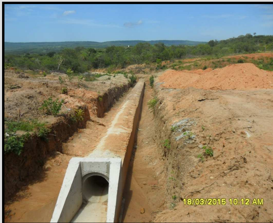
05 – Bueiro simples tubular de concreto no km 133+885,85% executado. Obra paralisada
