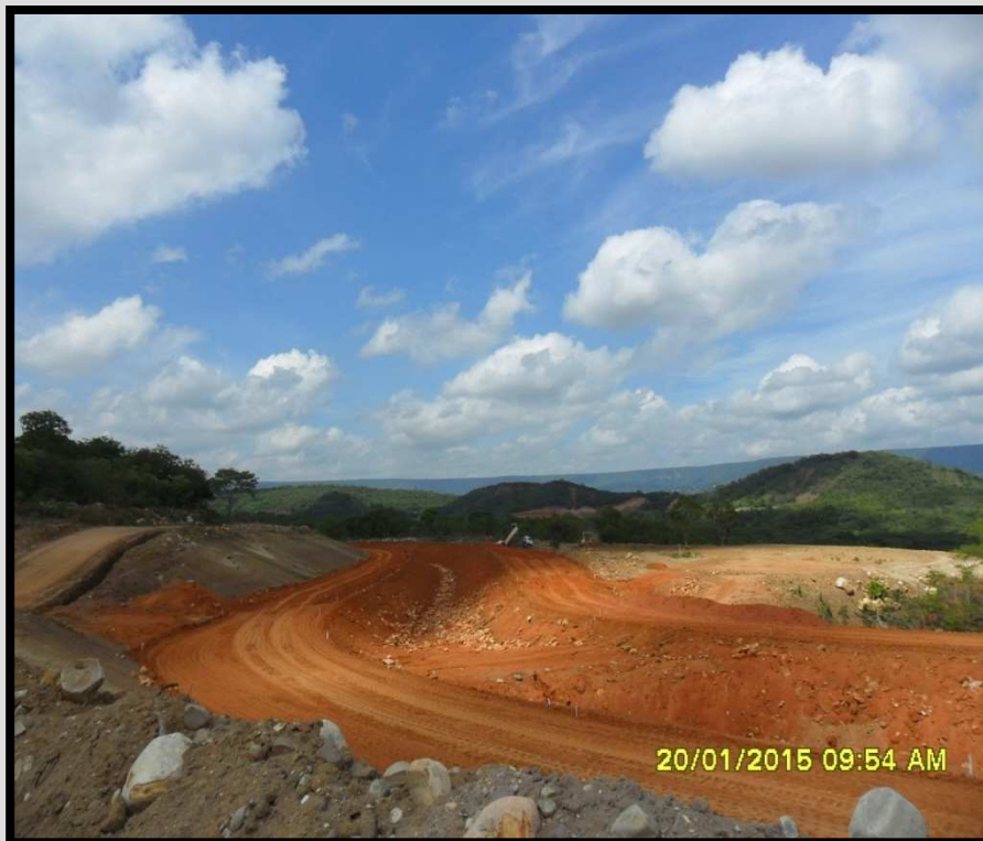
07 – Trecho de folhelho/argilito km 85+500 a 85+620. Aterro compactado (65% executado)
