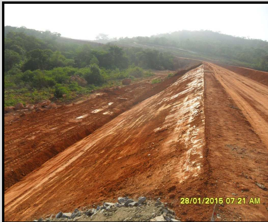
06 – Detalhe de regularização de talude executada em aterro compactado km 85+500 a 85+620
