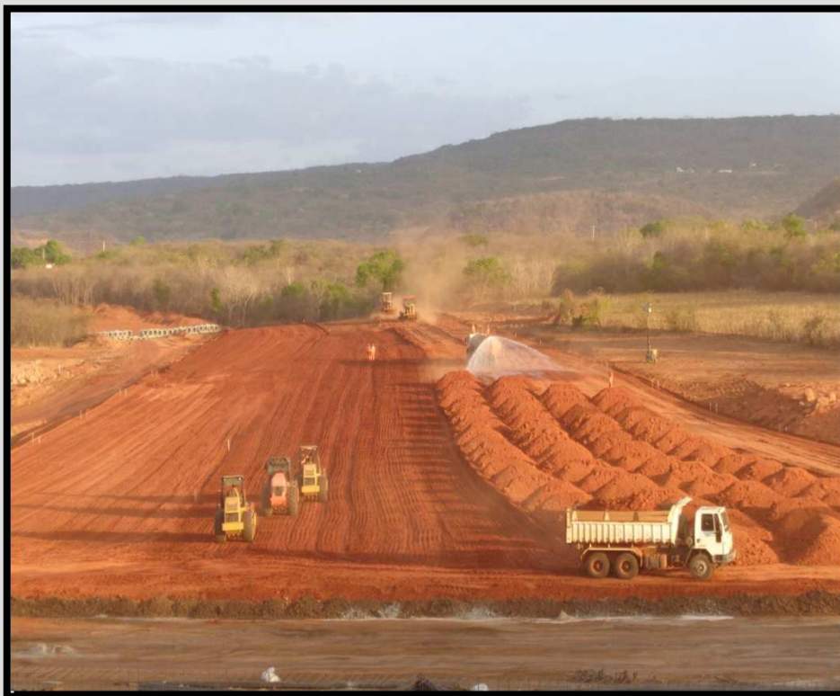
01 – Execução de Aterro Compactado - Canal 15A.1 - km 70+800
