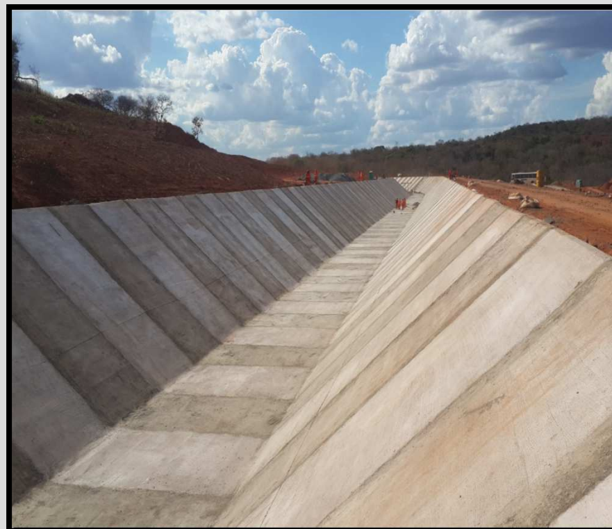
12 – Concretagem Seção Hidráulica - km 61+500
