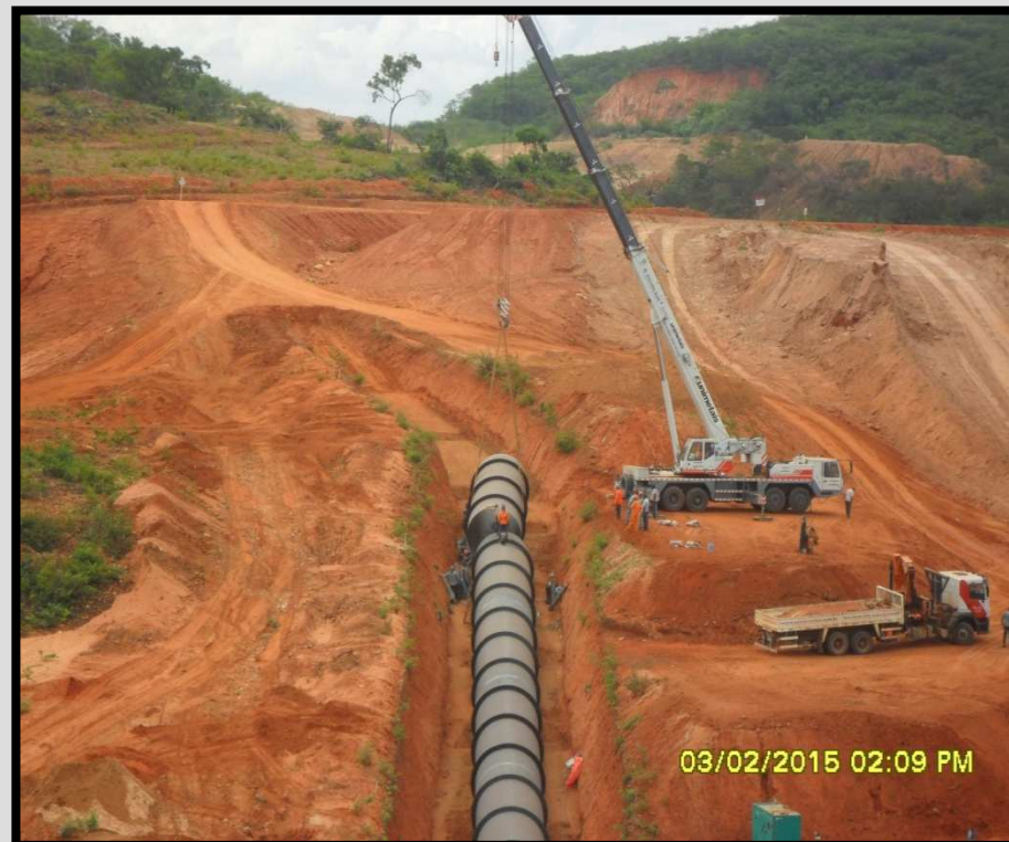
02 – Tubulação de aço carbono DN 2.800mm assentada em vala do Sifão Roncador 2 km 77+655,51 a 77+929,78. 34,78% executado. Obra paralisada
