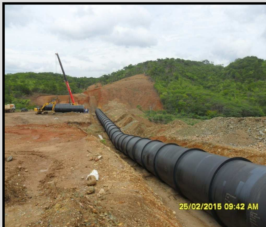
04 – Montagem da tubulação DN 2.800mm do Sifão Caldeirão km 138+870,00 a 139+200,00. 59,26% executado
