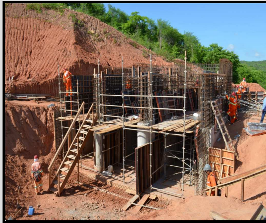
04 – Estrutura de Concordância do Emboque do Sifão Areia - km 59+000
