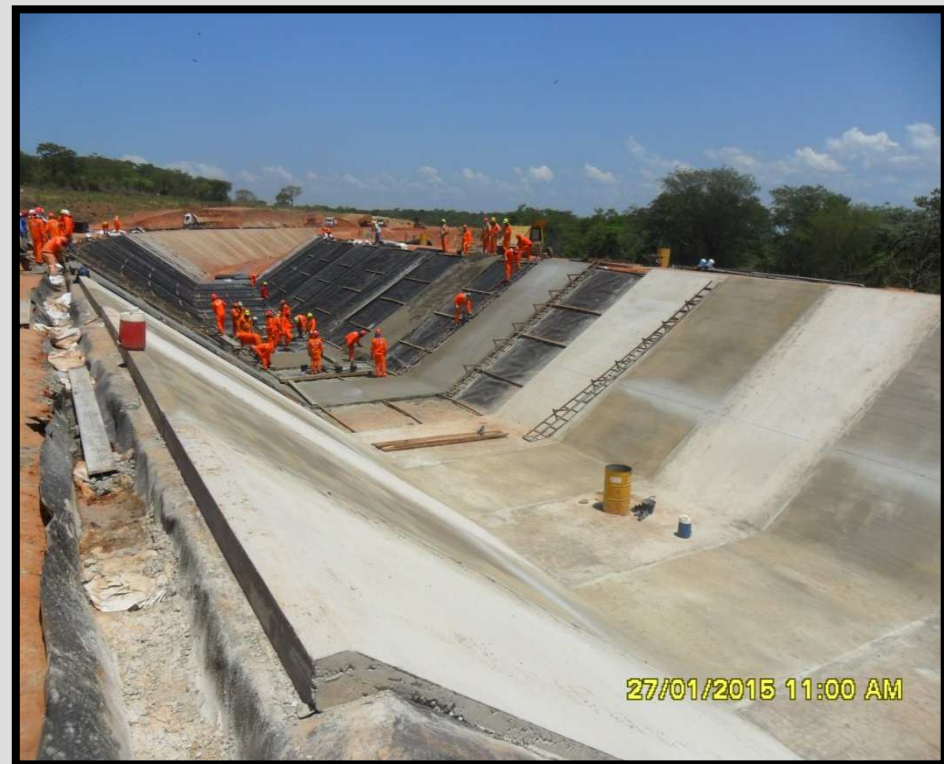
04 – Execução de placa de canal km 83+293 a 85+293. 7,35% executado
