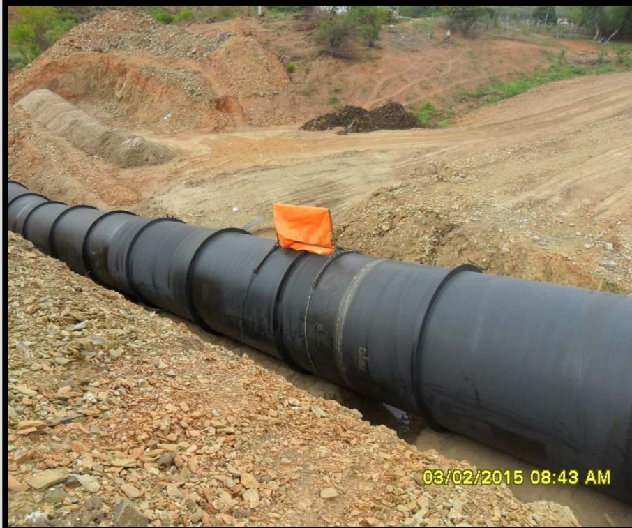
01 – Detalhe de tubulação assentada no Sifão Pai Mané km 127+818,62 a 128+139,20
