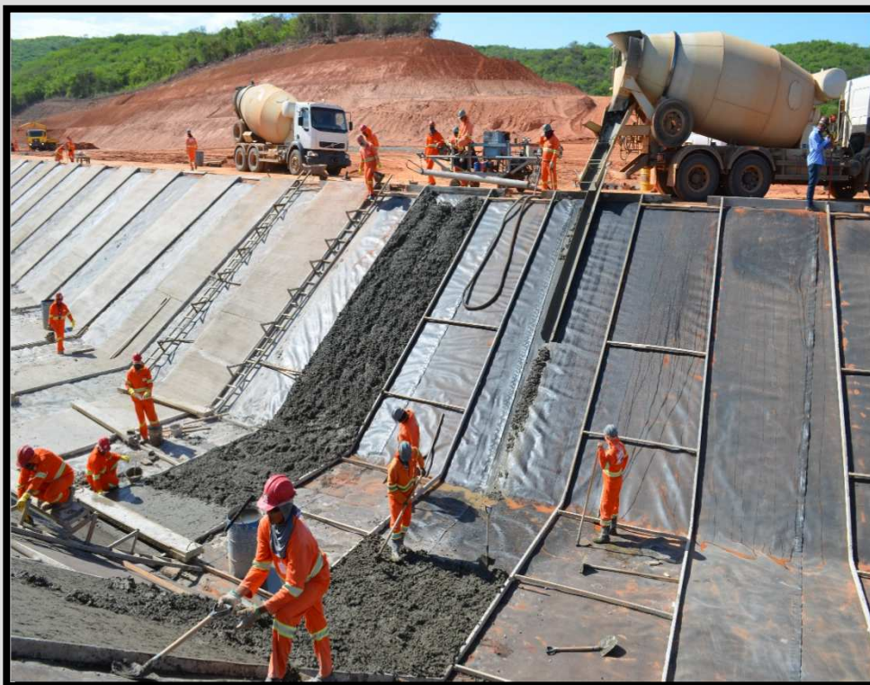
11 – Concretagem Seção Hidráulica - km 62+800
