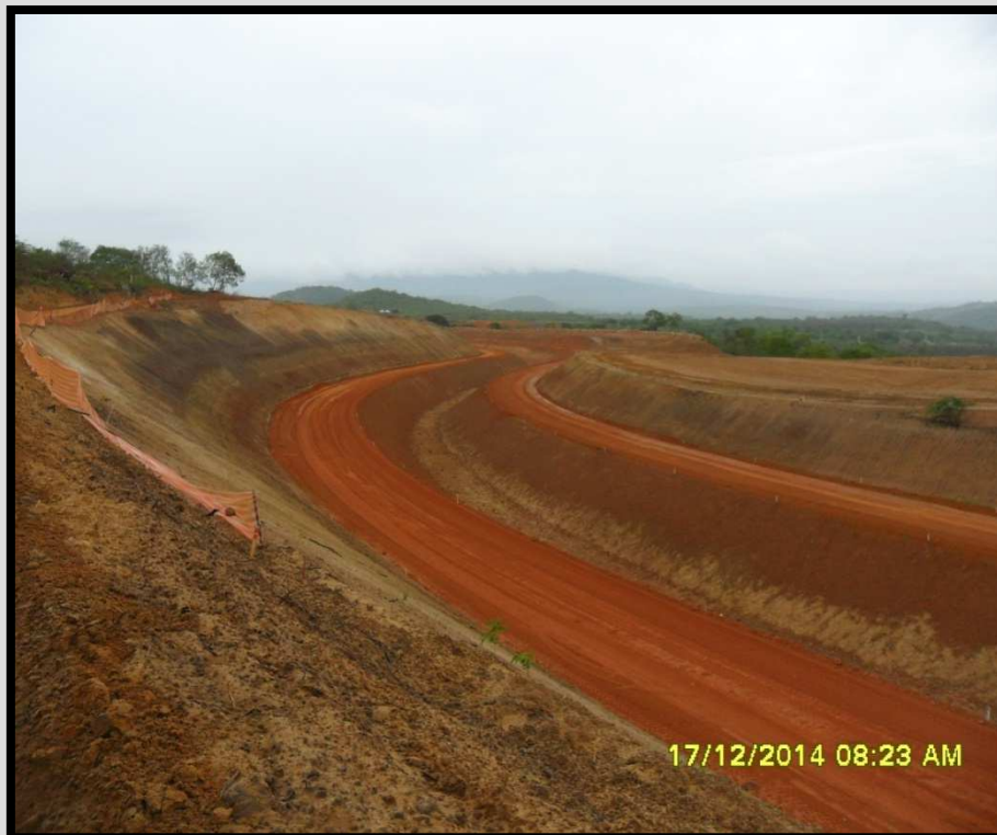
05 – Escavação de seção hidráulica km 84+700 a 84+820. 100% executado
