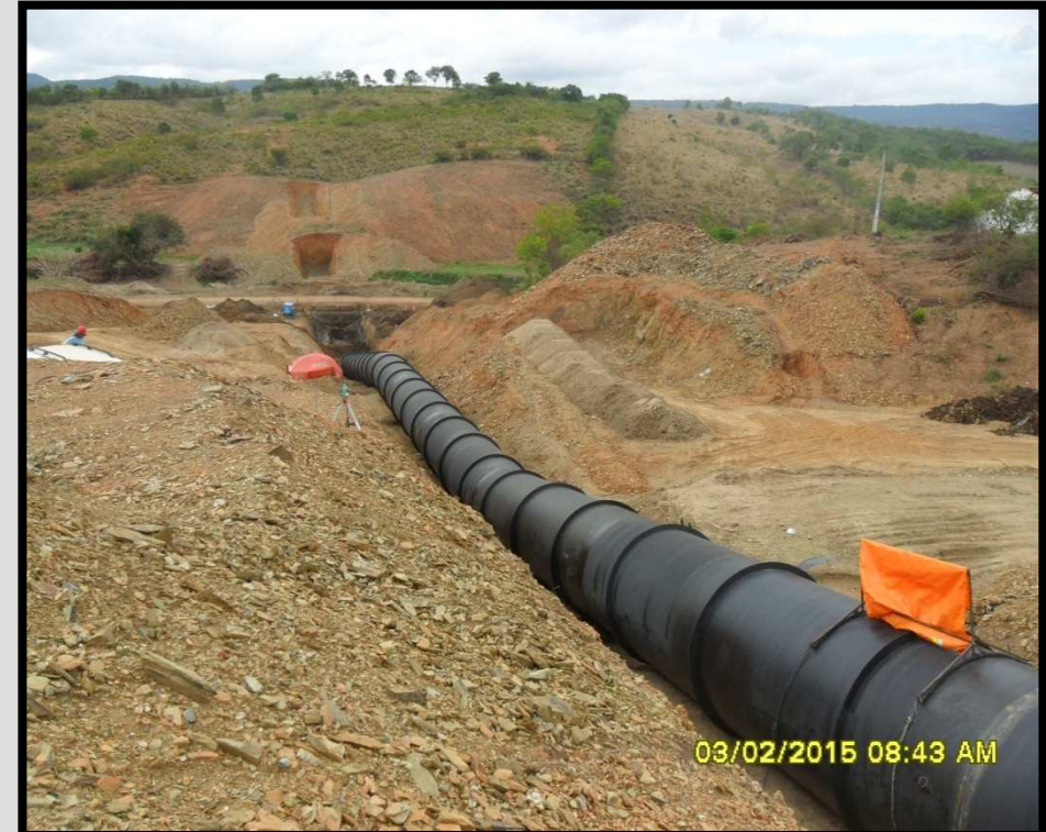
02 – Montagem da tubulação DN 2.800mm do Sifão Pai Mané km 127+818,62 a 128+139,20. 40,74% executado
