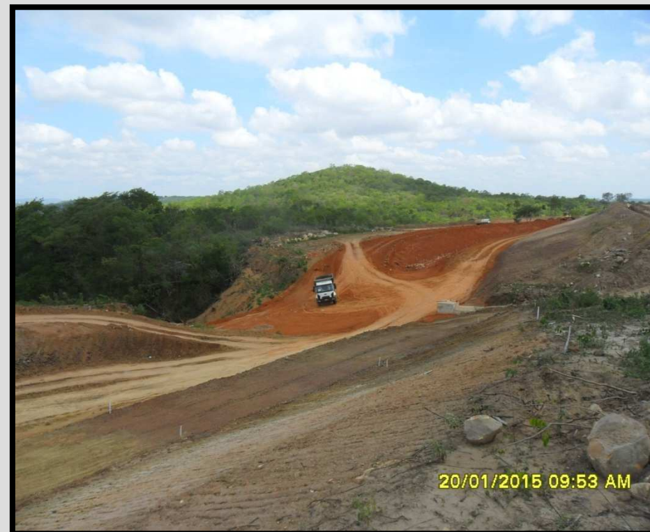
08 – Trecho de folhelho/argilito km 85+500 a 85+620. Aterro compactado (65% executado)
