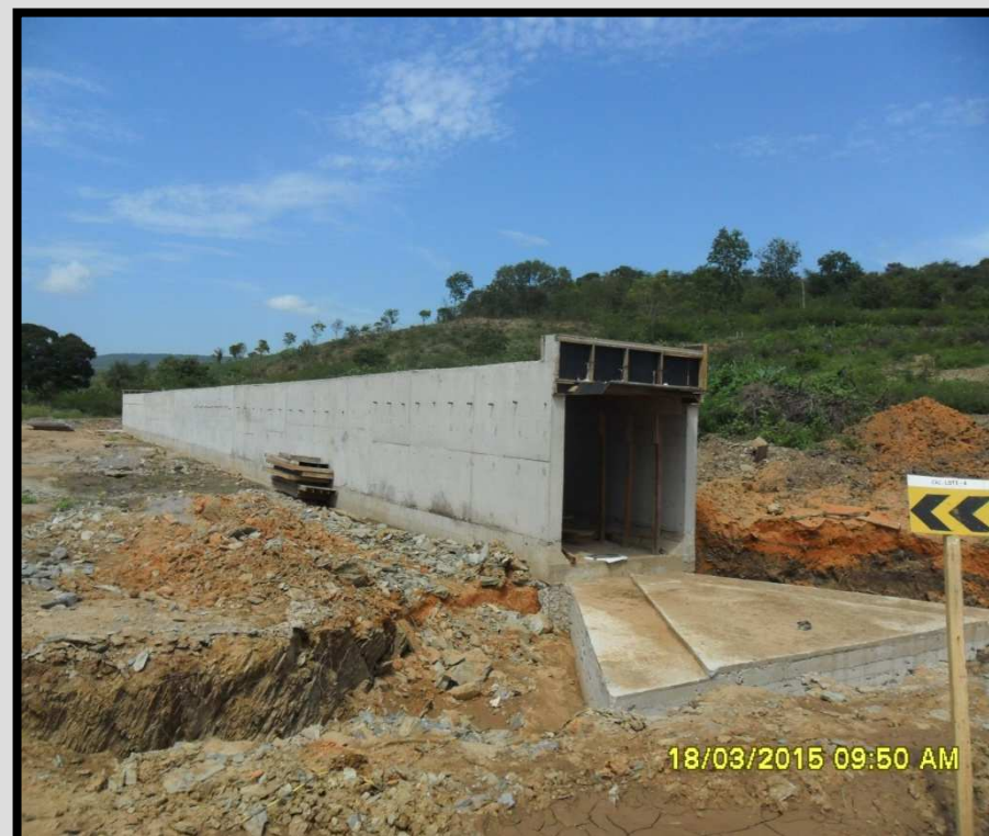
06 – Bueiro simples celular de concreto no km 134+577,95.90% executado
