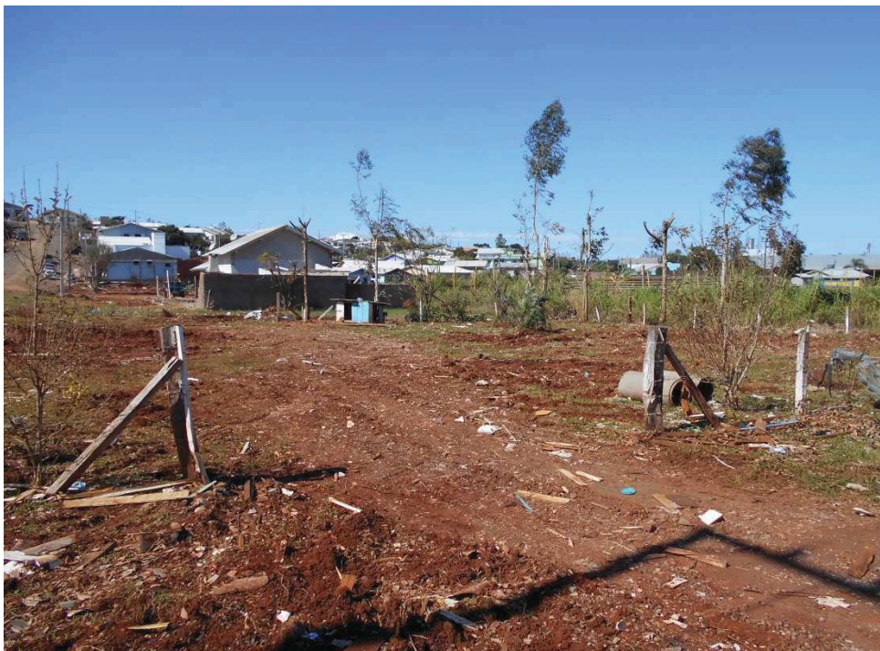
Foto 2. Local onde três casas de alvenaria foram totalmente destruídas, cujos escombros foram removidos, em Xanxerê (SC)
