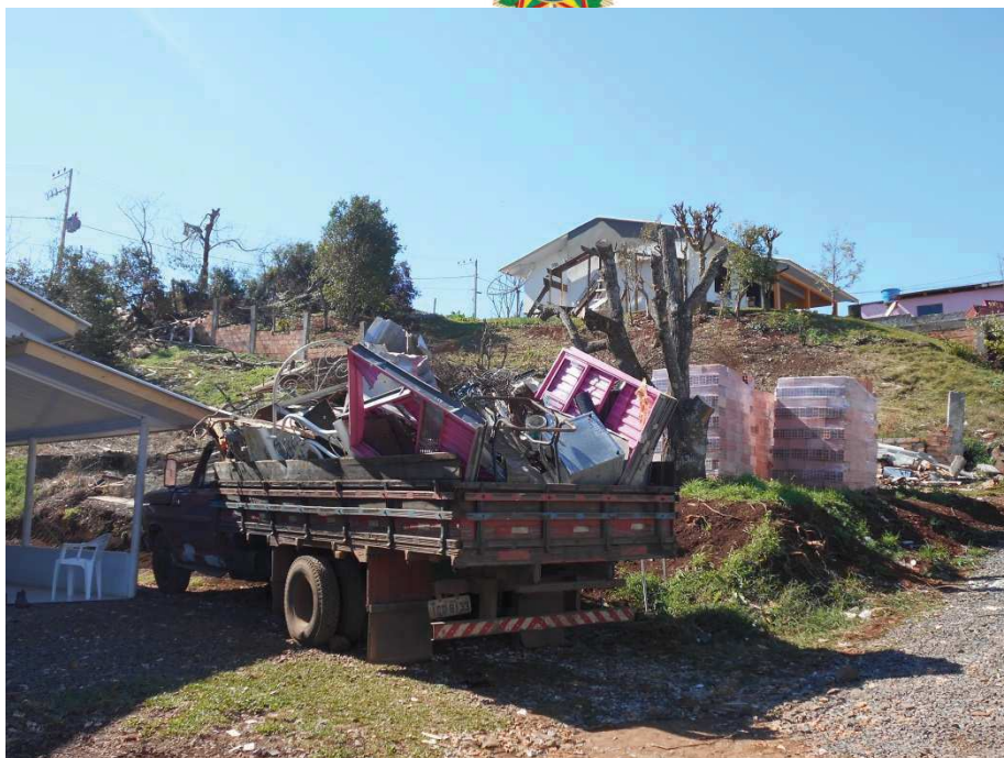
Foto 3. Remoção de escombros e material para construção de moradia totalmente destruída, em Xanxerê (SC)
