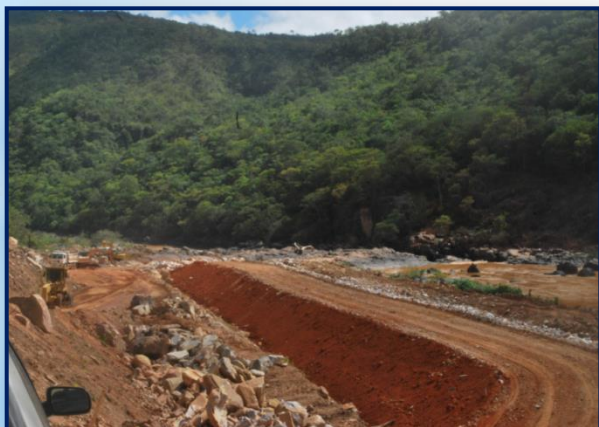
Barragem de Jequitaia - MG
