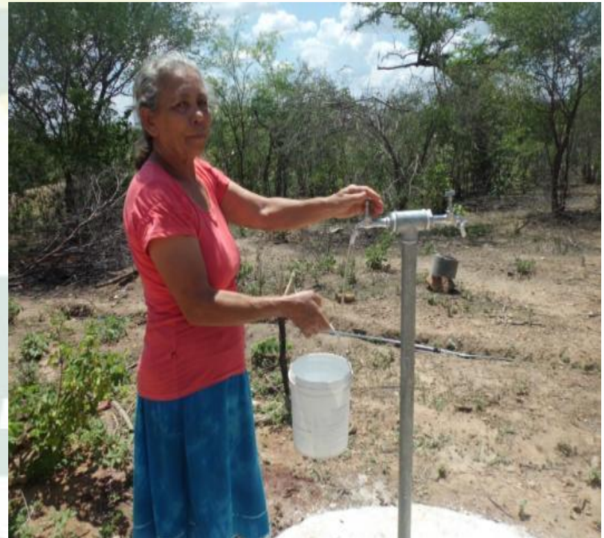
Chafariz sendo utilizado
