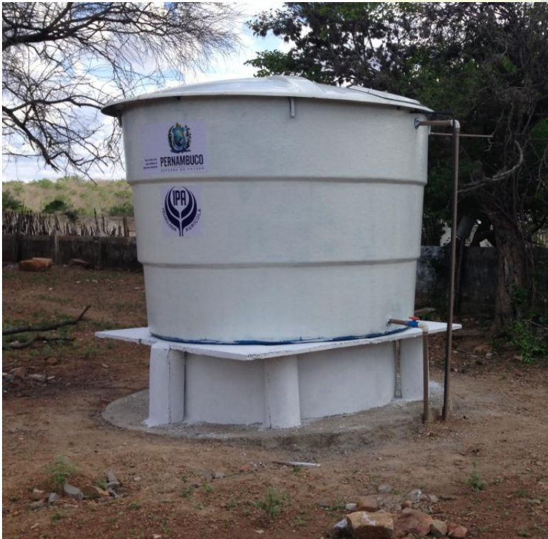
Reservatório instalado, pintado e com logo marcas do governo do estado e do IPA
