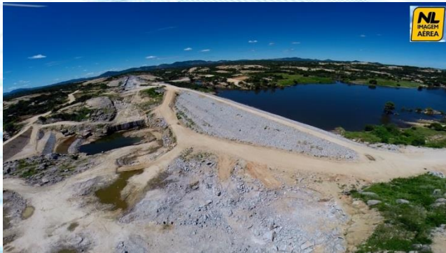
Ensecadeira e fundações da Barragem
