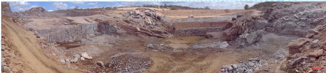
Escavações na calha do rio
