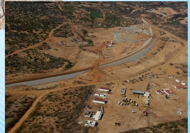
Barramento auxiliar I (terra)
