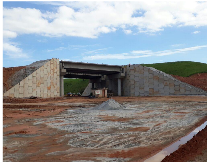
BR-101/ES/BA - Obras de implantação do contorno de Iconha – Interseção Sul
