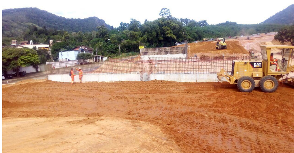
BR-101/ES/BA - Obras de implantação de interseção tipo diamante
