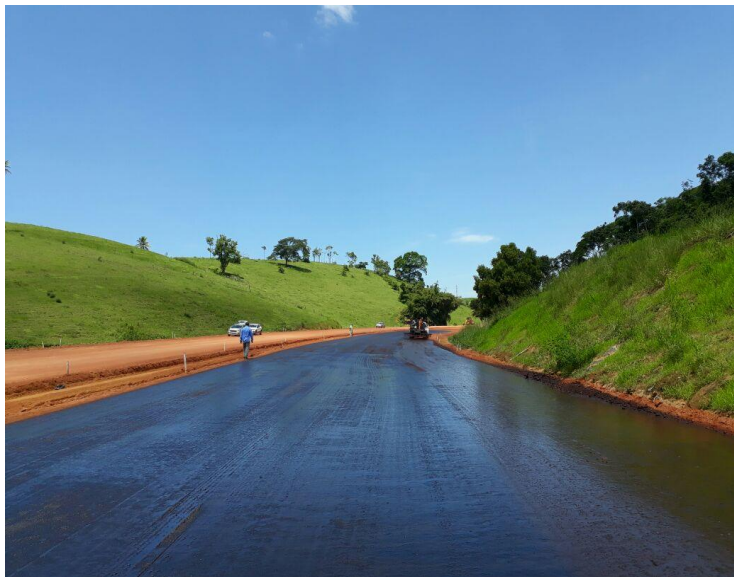
BR-101/ES/BA - Obras de implantação do contorno de Iconha – imprimação do trecho
