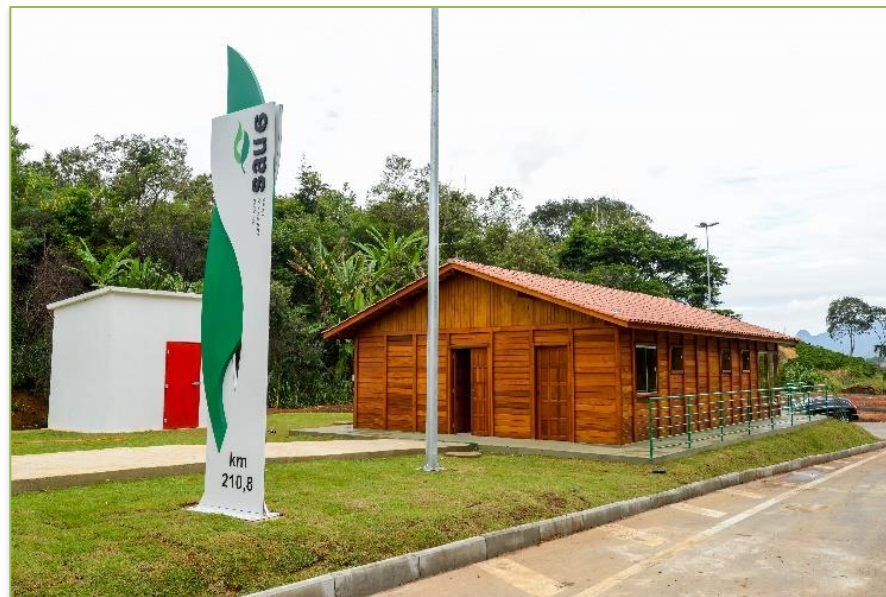
Base Operacional em Ibiraçu
