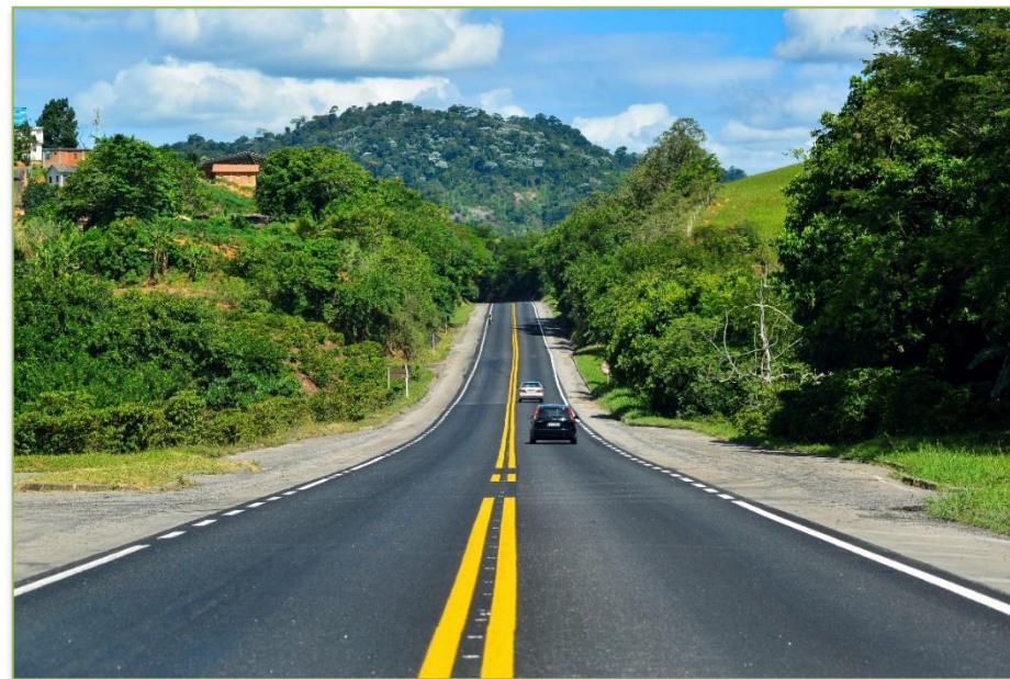
Recuperação do pavimento e sinalização horizontal
