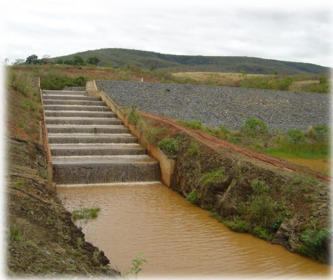
Barragem Matrona - Vertedouro
