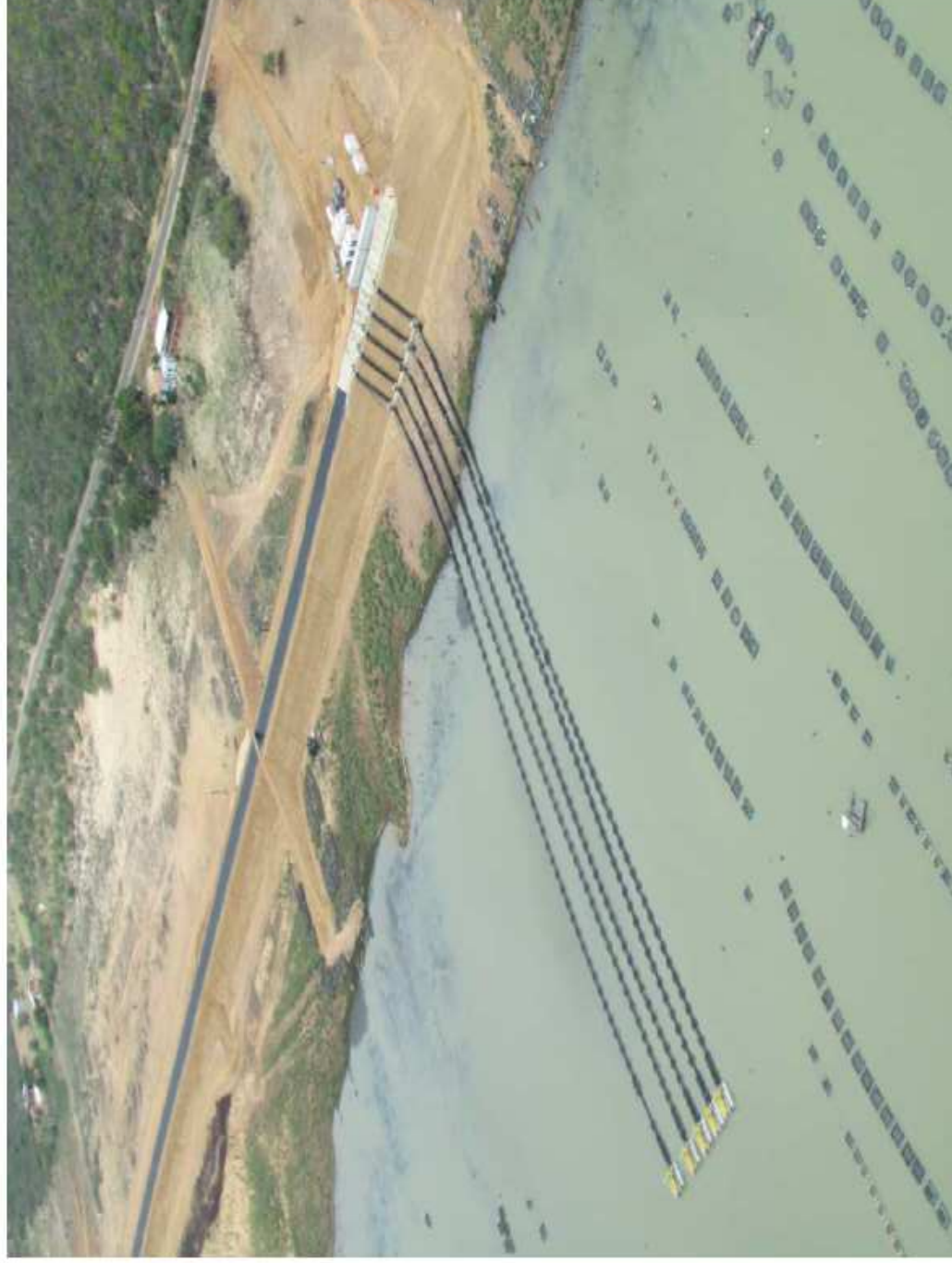
Foto 3. 15/01/2016 → Cota 381,06 metros → 2,2% do Volume Útil – Ampliação do sistema de captação do Projeto Nilo Coelho, para cotas mais baixas no reservatório de Sobradinho.
