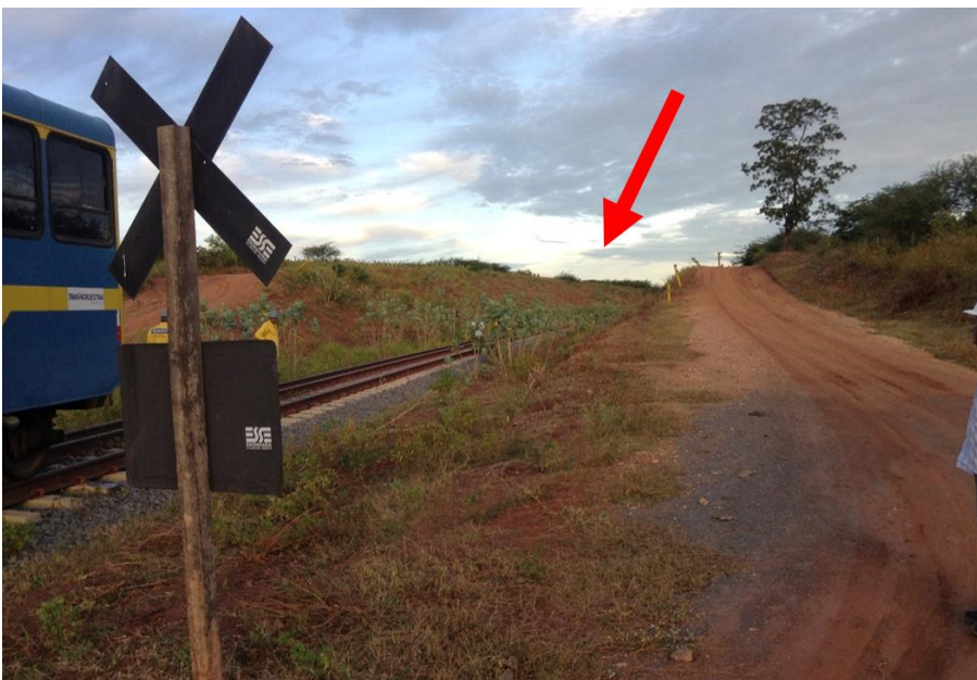
Viaduto não construído
