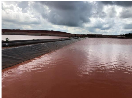
Figura 5 – Bacia de rejeitos (Depósitos de Resíduos Sólidos - DRS 1) com capacidade máxima atingida.
