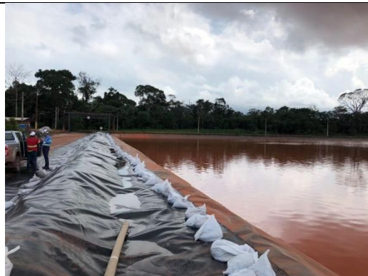
Figura 6 – Bacia de rejeitos (Depósitos de Resíduos Sólidos - DRS 1) com capacidade máxima atingida.
