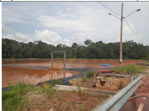
Figura 9 – Mangueiras próximas à Bacia de rejeitos (Depósitos de Resíduos Sólidos - DRS 1).
