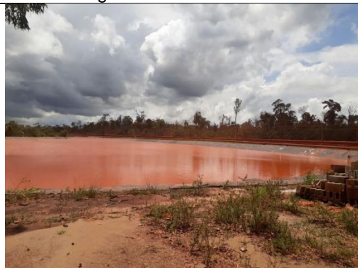
Figura 8 – Bacia de rejeitos (Depósitos de Resíduos Sólidos - DRS 1) com capacidade máxima atingida.
