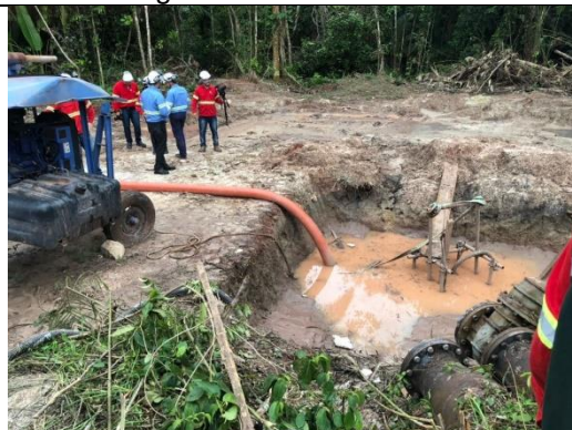
Figura 10 – Escavação feita pela Hydro Alunorte fora área da empresa, próximo a DRS 1.
