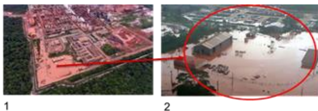
A área alagada, na foto 2, é a SUMP 45, área interna da refinaria construída para captar água da chuva das áreas administrativas.
