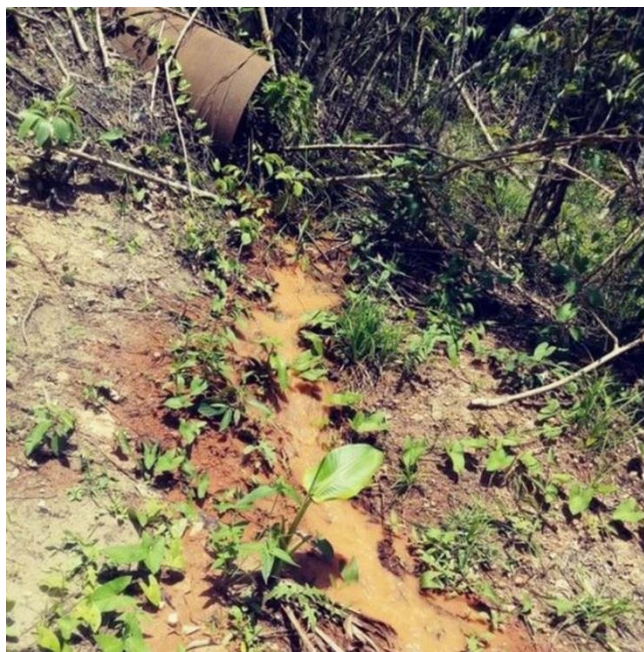
Figura 1 – “Tubo Clandestino” verificado em vistoria.
