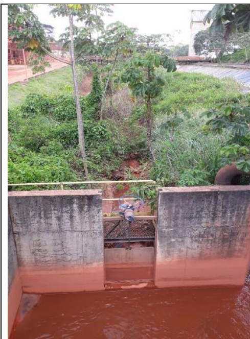
Figura 20 – Vista geral da estrutura
