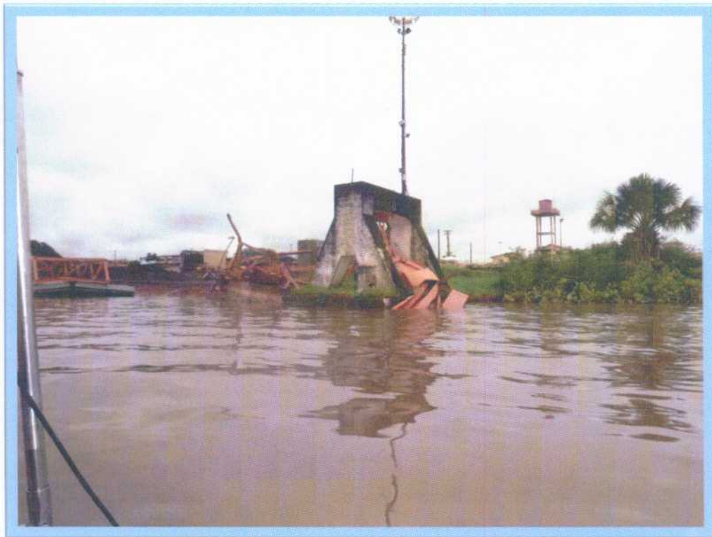
Figura 13: estrutura de concreto que apoiava o píer flutuante em sua lateral.
