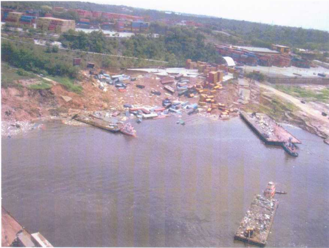
Figura 04: Vista da área do acidente do pátio alfandegado. À direita, rampa de acesso da balsa de carretas.
