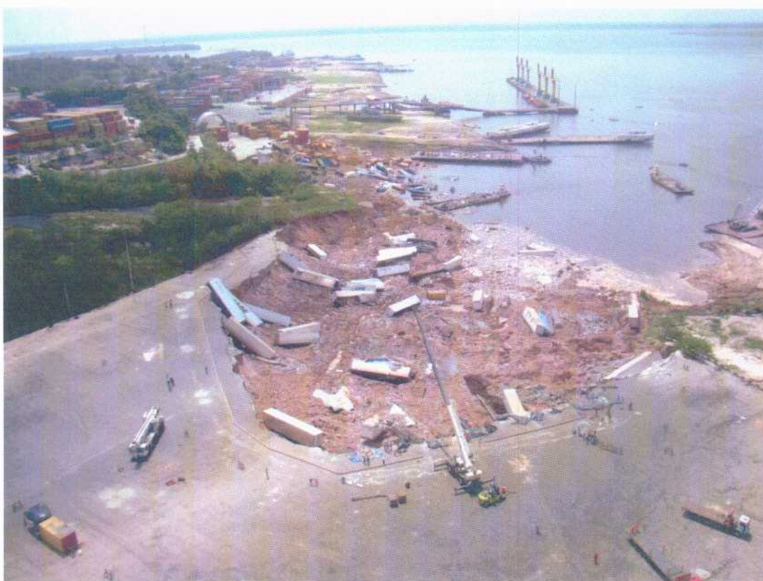
Figura 01: Vista aérea do pátio ATR, mostrando o arco de ruptura. Na sequência, área afetada do pátio alfandegado, rampa de acesso e cais flutuante.
