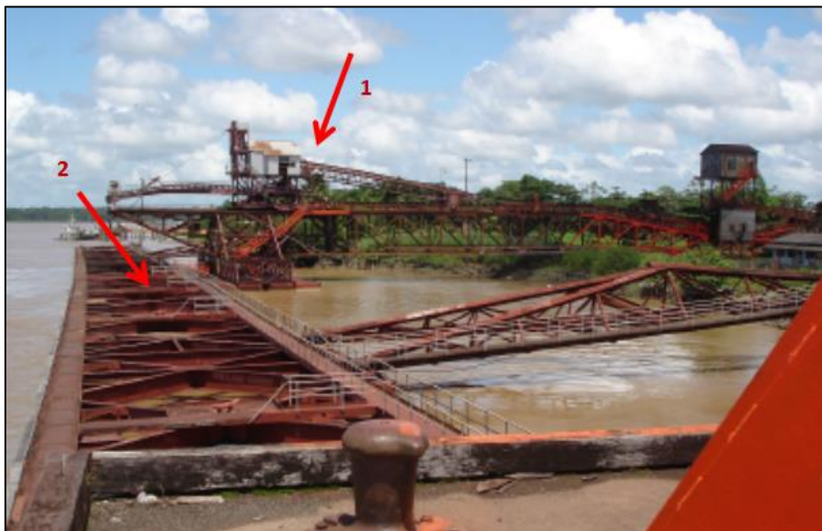
Figura 17 - Carregador de navios (1) e pier flutuante (2) antes do início das obras.
