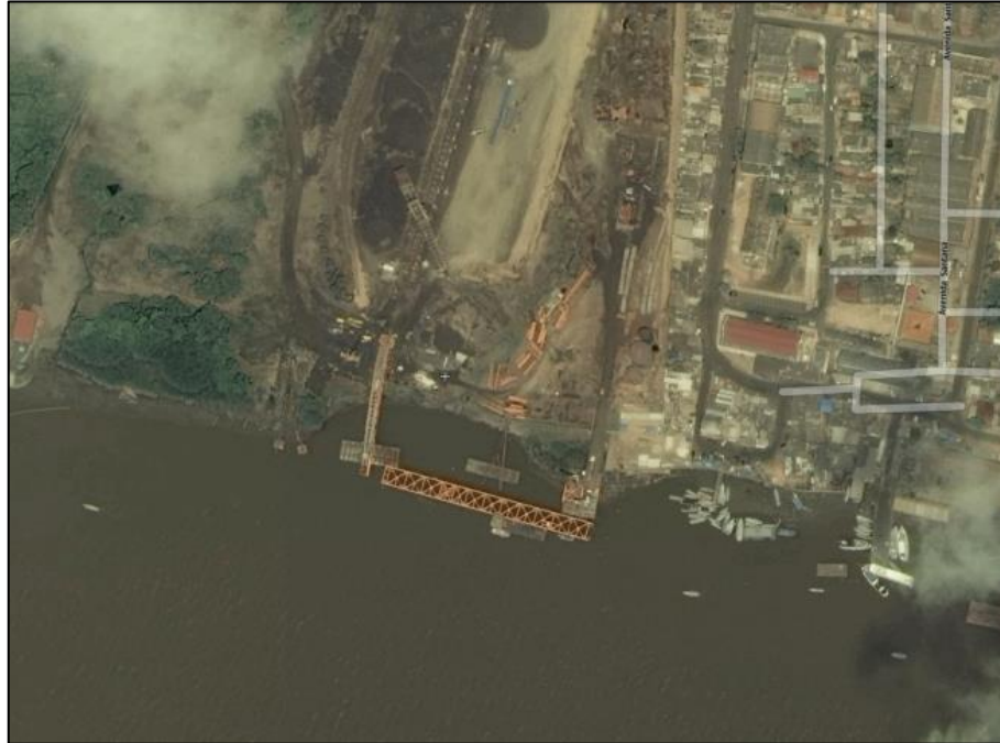
Figura 26 - Novo píer em processo de montagem, com os braços antigos conectados nas rótulas e apoiados sobre flutuadores.
