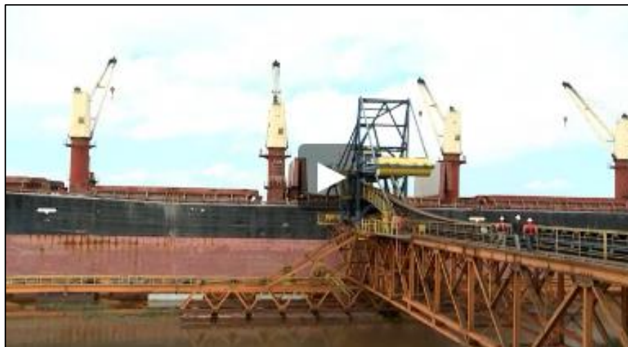
Figura 31 - Operação de carregamento de minério.
