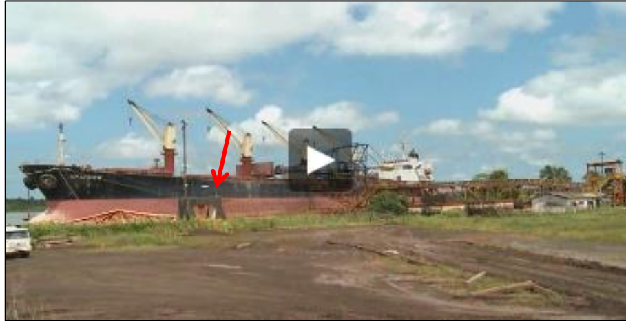
Figura 32 - Outra vista do mesmo local. A seta assinala a localização do bloco de concreto estaqueado onde se apoia a treliça metálica que fixa o pier flutuante à margem - Lado leste.
