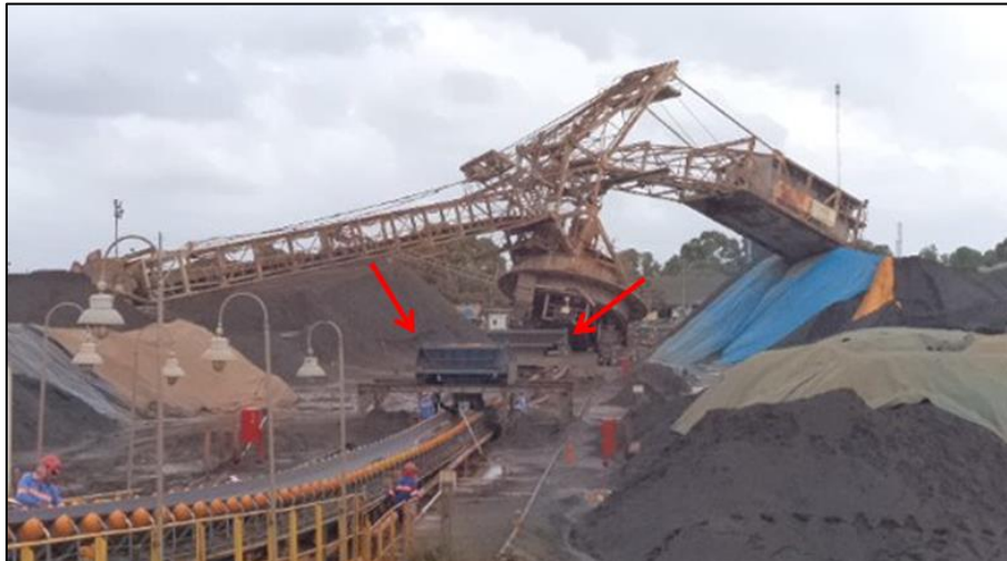
Figura 85 – Foto de fevereiro de 2013, mostrando duas moegas instaladas após a retomadora.
