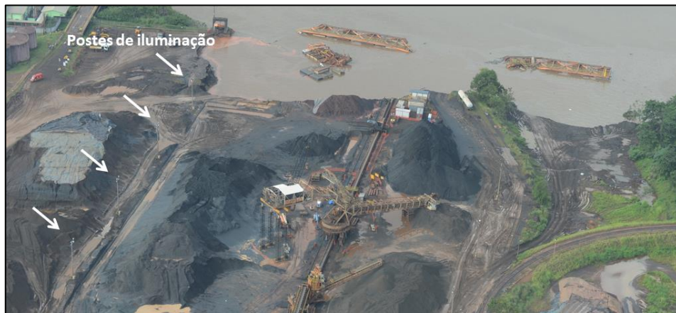
Figura 88 – Foto aérea com as referências (postes de iluminação e caixas de decantação) após o deslizamento.
