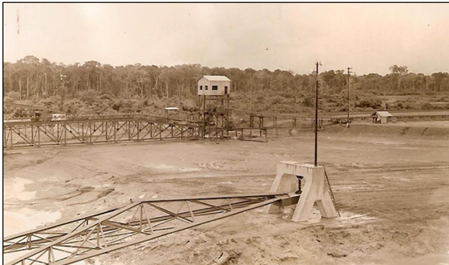
Figura 5 - 1956: Porto da ICOMI em fase final das obras, com o desnível original totalmente descaracterizado por obras de terraplenagem e aterro.
