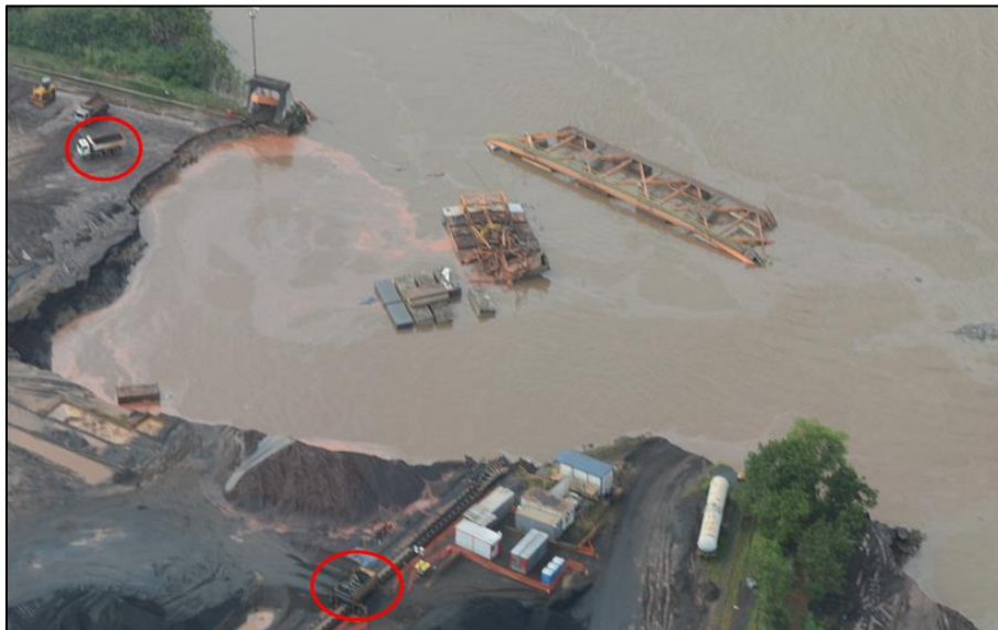
Figura 79 – A foto aérea após o deslizamento permite a comparação visual entre as dimensões dos caminhões utilizados e a moega. Com tamanho compatível, é possível utilizar uma pá mecânica de mesma capacidade, de modo a equilibrar as operações de carregamento.
