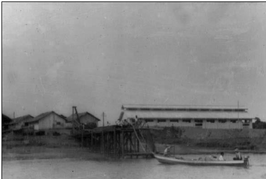
Figura 3 – Prédio do “Super Fácil” ao fundo, com primeiro píer fixo utilizado pela ICOMI. Parte do primeiro píer fixo desabou em Novembro/1955, sem vítimas.
