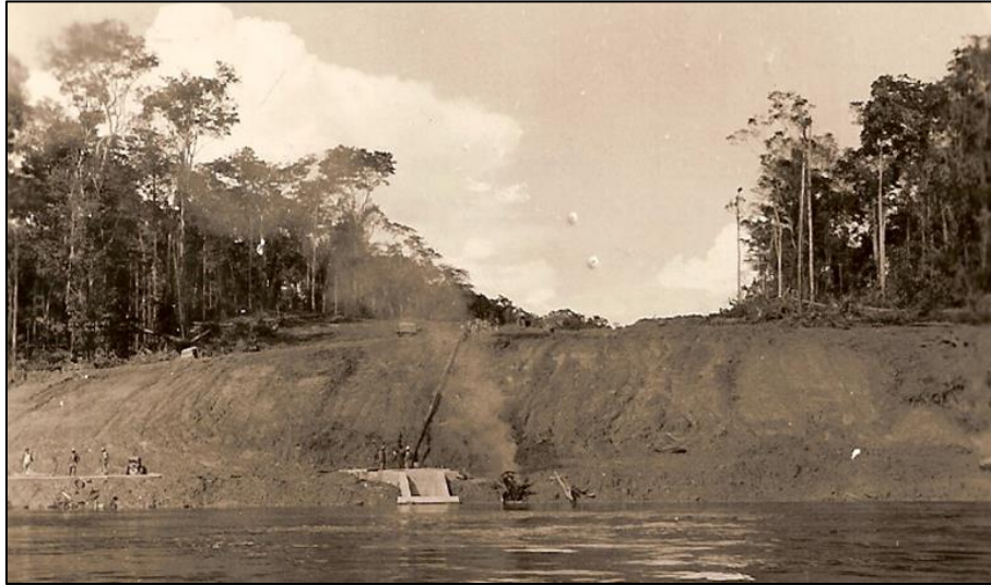
Figura 4 - 1954: Porto da ICOMI antes do início das obras. A referência tirada pela estatura das pessoas sugere um desnível acima de 10 metros entre o nível do rio e o topo do talude.
