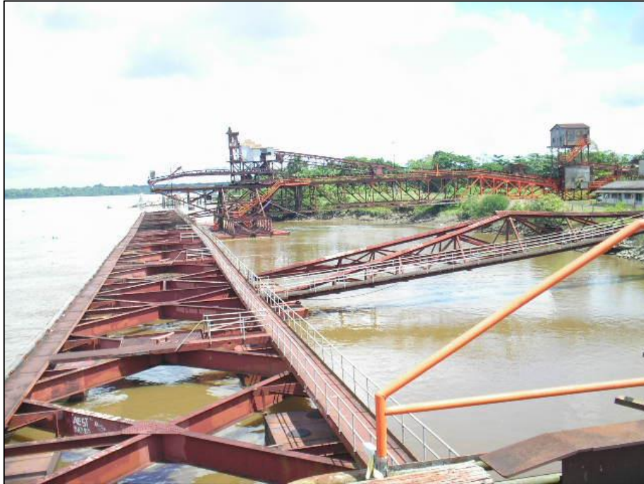
Figura 24 - Estrutura central parcialmente pintada e ainda suportando o carregador antigo.
