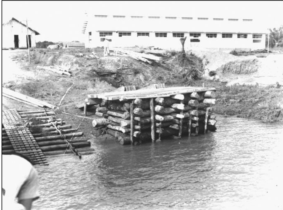
Figura 2 - 1946: Área posteriormente utilizada pelo Porto da ICOMI. Início da construção do primeiro píer fixo e o prédio do “Super Fácil” ao fundo.
