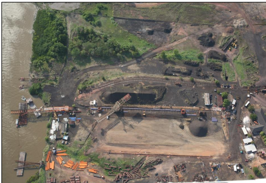
Figura 25 - Píer antigo desmontado, novos equipamentos sendo instalados sobre a estrutura central antiga, braços antigos fixados nas rótulas e apoiados sobre flutuadores.
