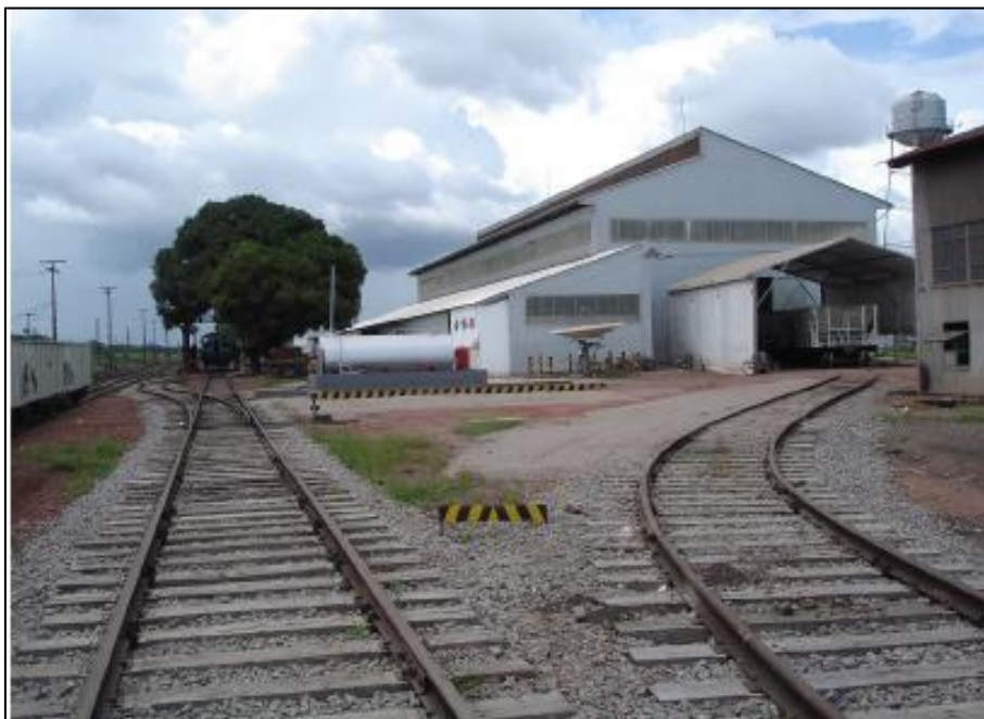
Figura 21 - Galpão de apoio.
