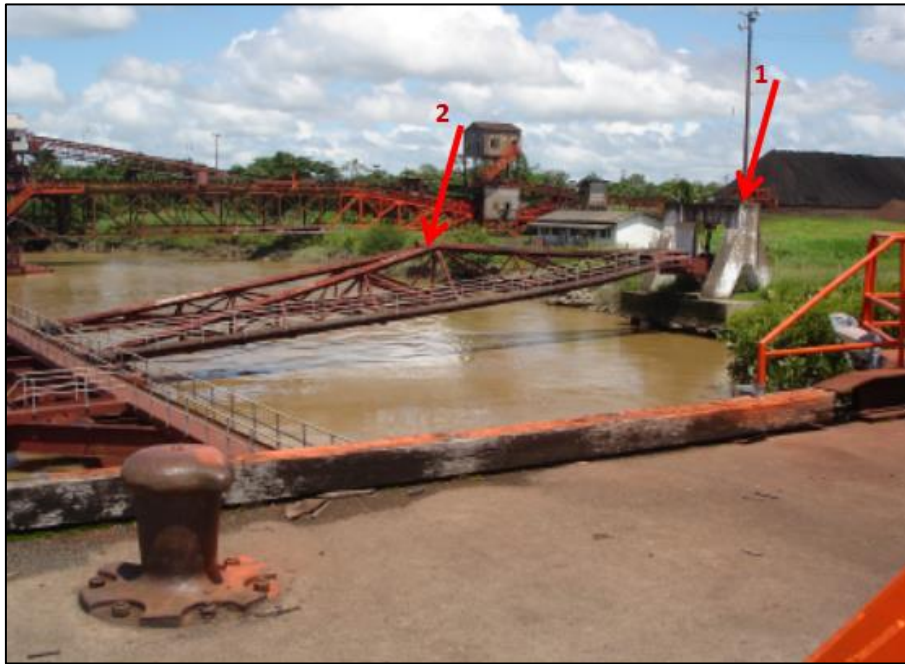
Figura 16 - Bloco de concreto estaqueado (1) de apoio à treliça metálica de ligação ao pier flutuante (2) – Lado leste
