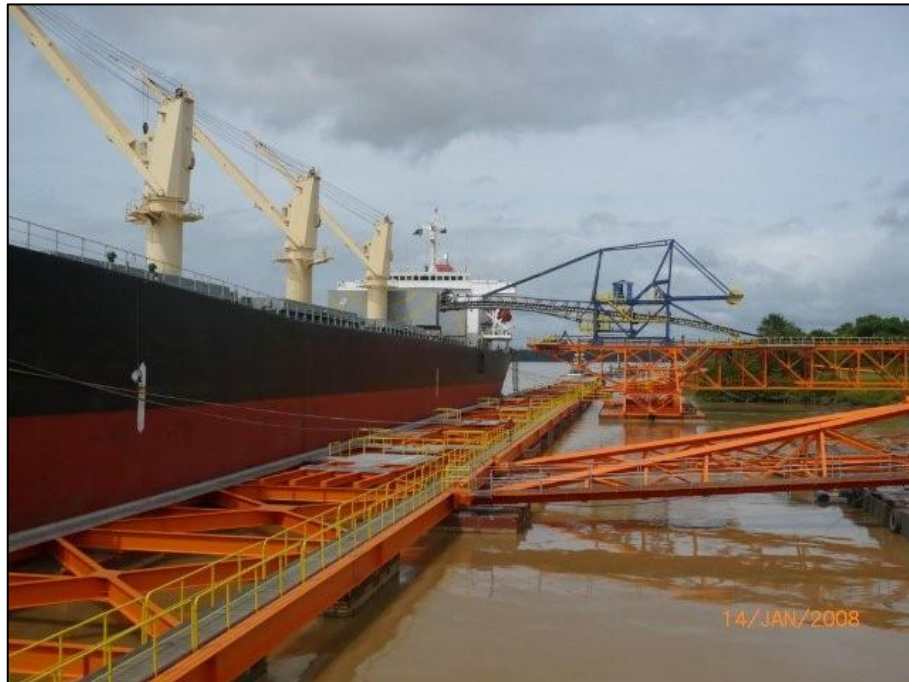
Figura 30 - Estrutura de embarque totalmente revitalizada, já em processo de carregamento.
