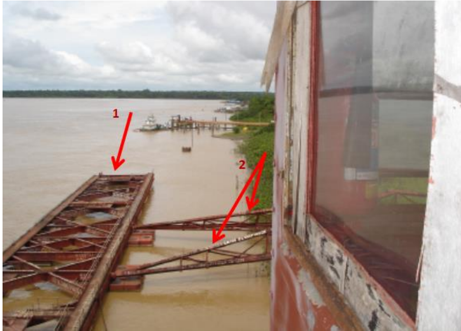
Figura 18 - Extremidade oeste do píer flutuante (1) e respetiva treliça metálica (2) de fixação ao bloco de concreto estaqueado.
