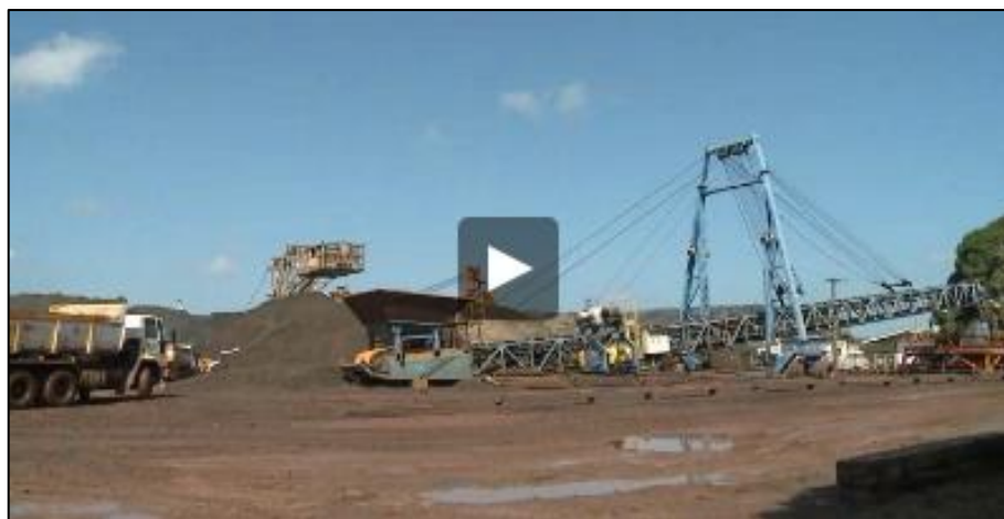
Figura 34 - Outra vista do pátio de estocagem.
