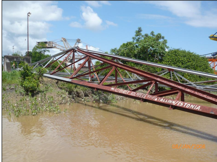
Figura 28 - Braço oeste em aparente processo inicial de revitalização.
