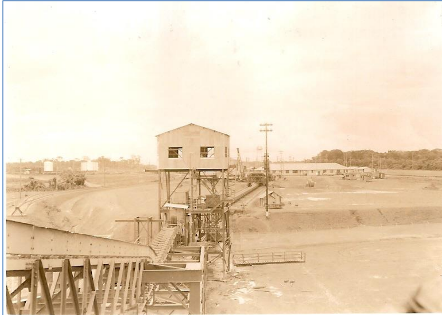
Figura 6 - 1956: Porto da ICOMI com vista do aterro inicial.
