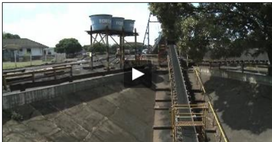
Figura 35 - Moega fixa para recebimento ferroviário de minério.
