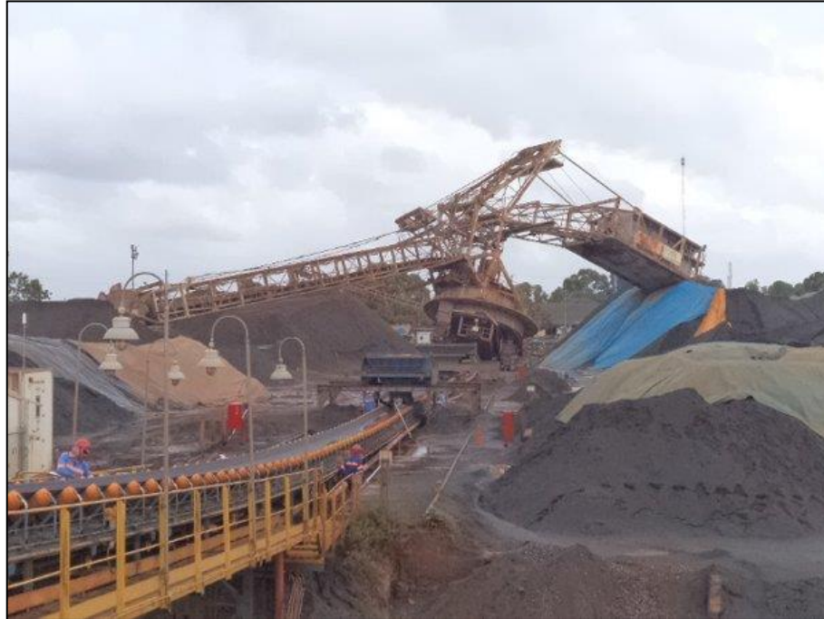
Figura 39 – Pilha de minério avançada. Retomadora avariada ao fundo, apoiada sobre pilha de minério no pátio de armazenamento.
