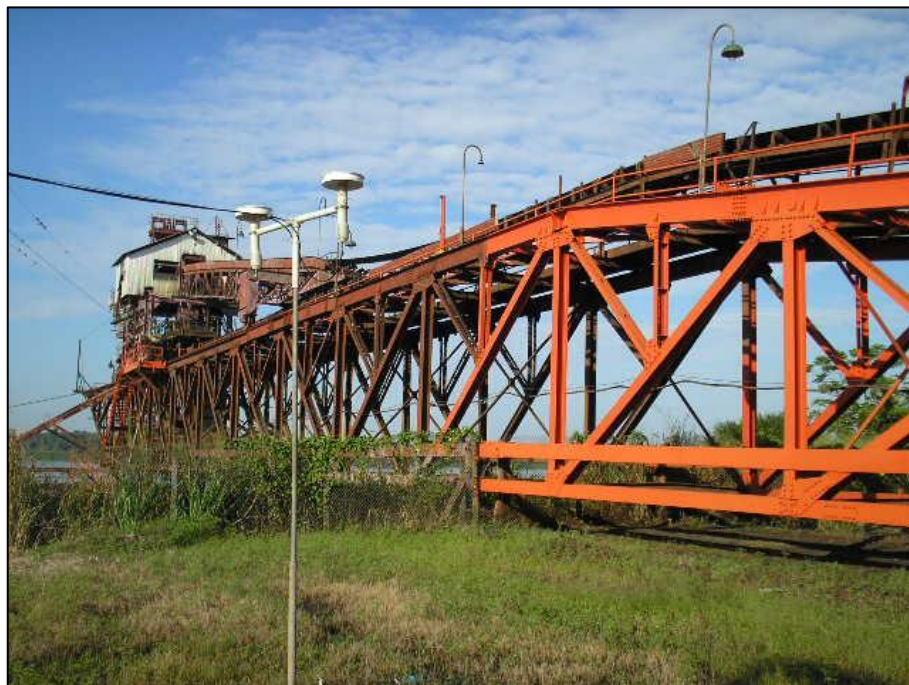
Figura 23 - Estrutura central parcialmente pintada (até a cerca), ainda com a antiga torre de amostragem.
