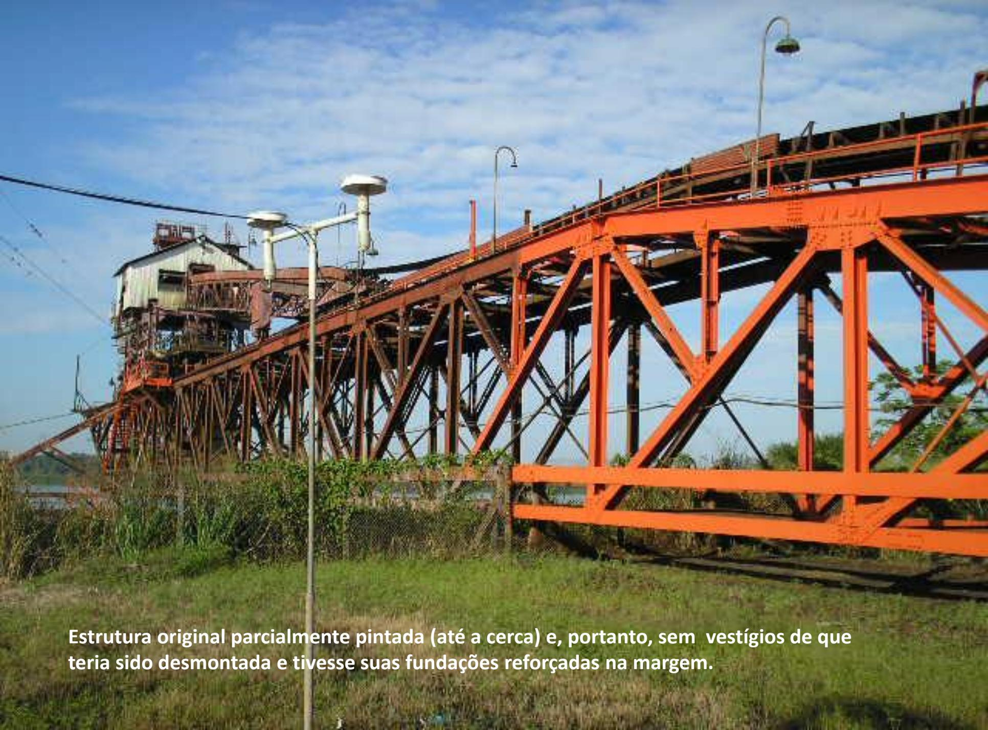
Estrutura original parcialmente pintada (até a cerca) e, portanto, sem vestígios de que teria sido desmontada e tivesse suas fundações reforçadas na margem.
