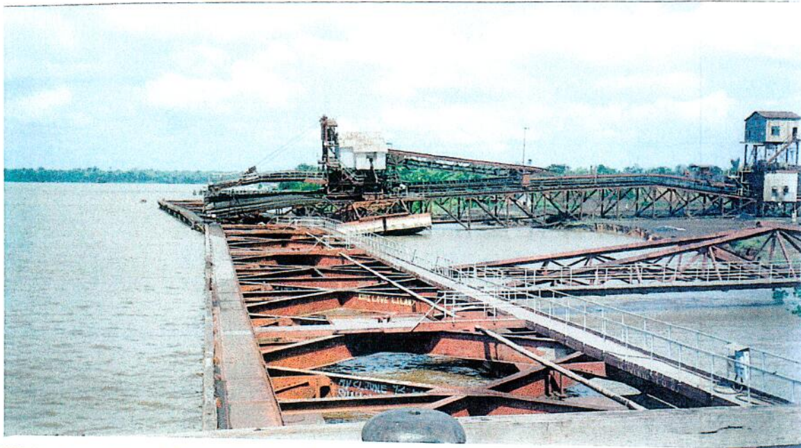
FOTO 3 - Na direita da foto pode ser visto o novo contorno da margem do rio após o desmoronamento. É visto também o desalinhamento do pier flutuante.
