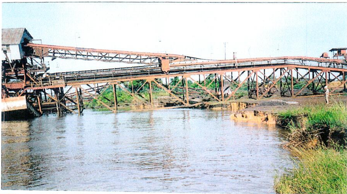
FOTO 4 - Em outro ângulo é mostrado a nova crista do talude após o deslizamento.
