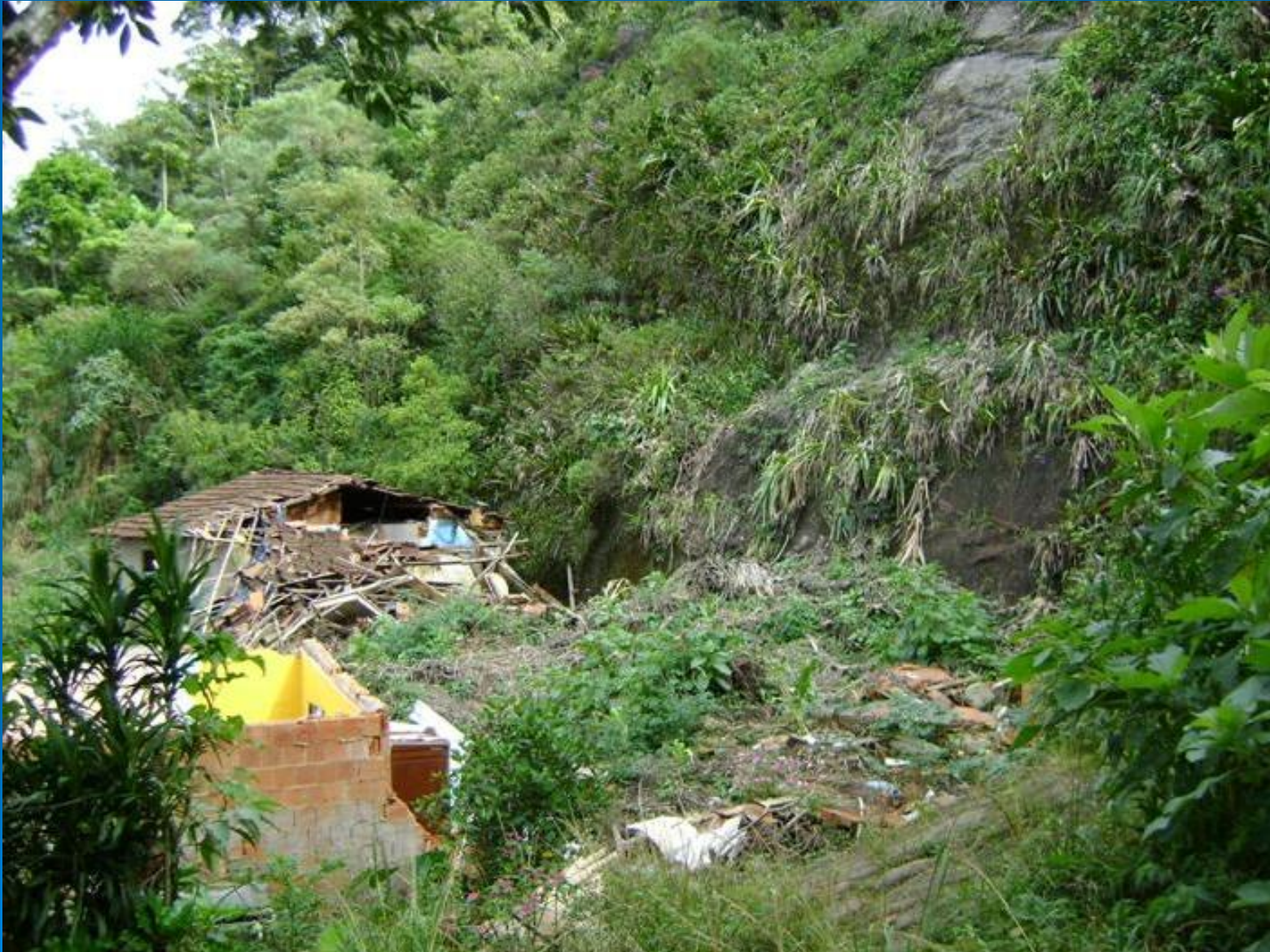
Casas atingidas por deslizamento de terra que ocasionou em duas vítimas fatais. Foto F.S. Lima.
