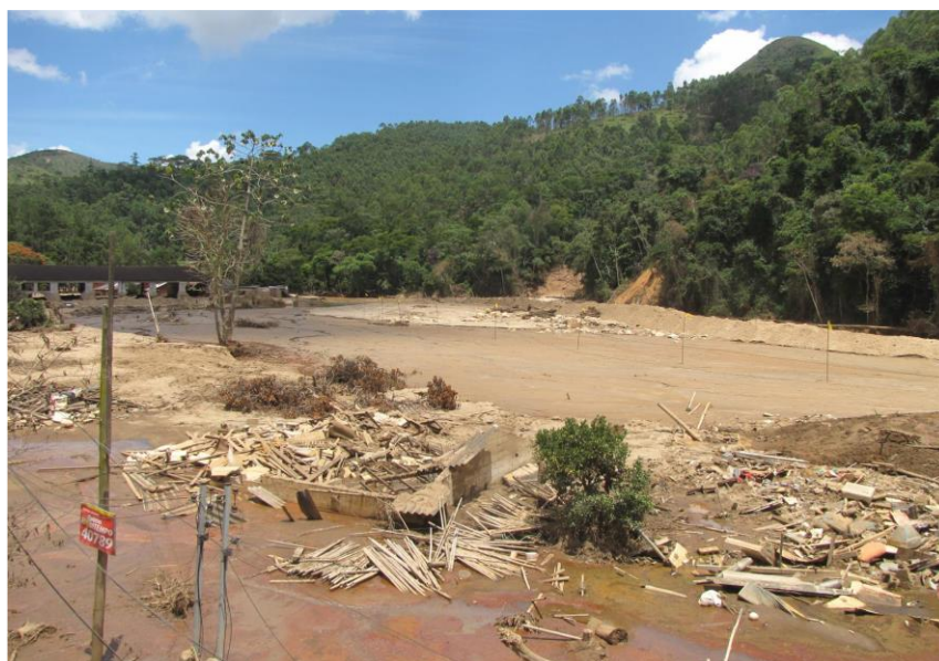
Figura 3. Desastre de 2011: casas situadas em área de preservação permanente, rio Cuiabá.
