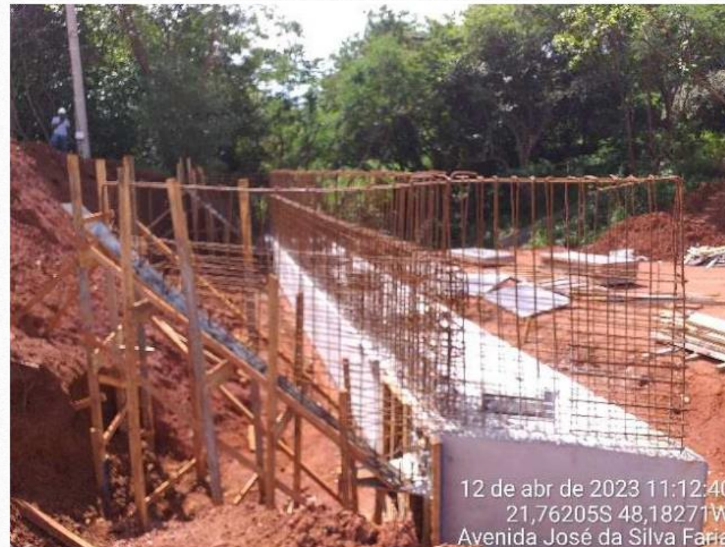
Foto 9 - Bloco de apoio do eixo 2 concretado
