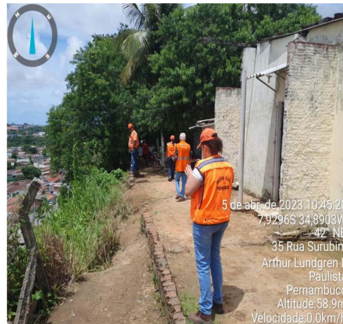
RUA SURUBIM - R$ 1.577.215,75
