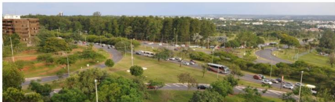
Obras do viaduto na Epig devem começar em abril, e a conclusão está prevista para 10 meses depois. Foto: Renato Araújo/Agência Brasília
