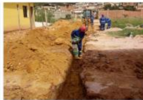
Compactação de vala (rede coletora)
