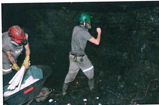
Preparação da galeria com colocação de explosivo para derrubada da camada.
