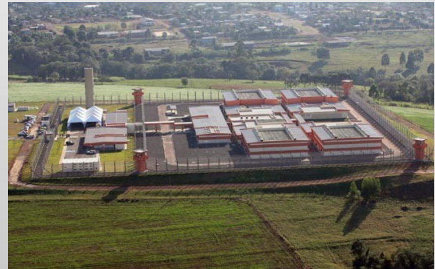
Penitenciária Federal de Catanduvras - PR
