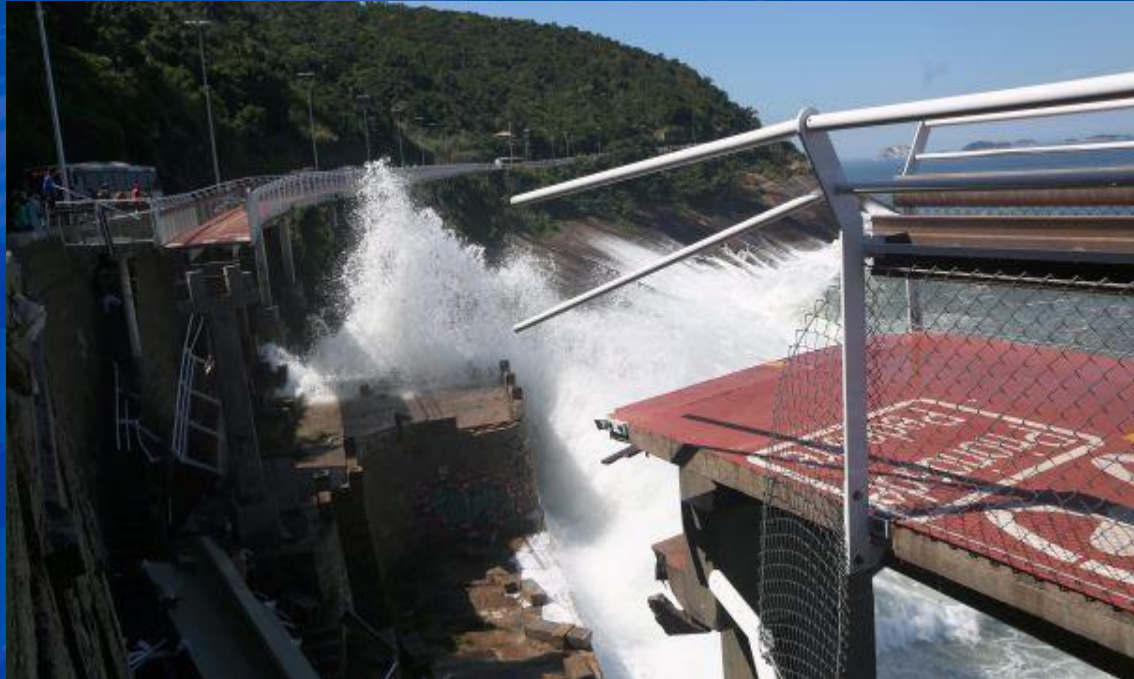
Ciclovía Tim Maia, na Avenida Niemeyer, no Rio de Janeiro
