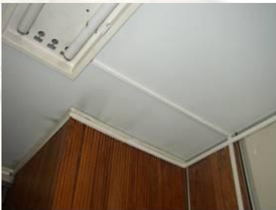
Adaptação de canaleta em luminária
