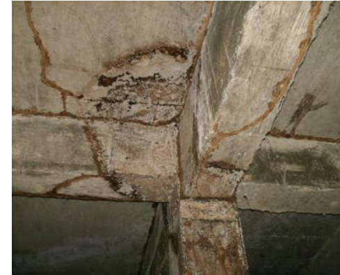
Infiltrações graves nas lajes
