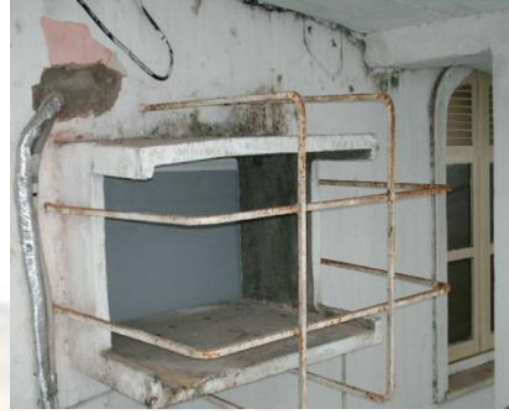
Estado geral da edificação.
