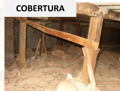
Estrutura de madeira do telhado
