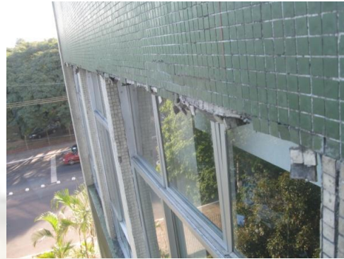
Precipitação de revestimento
