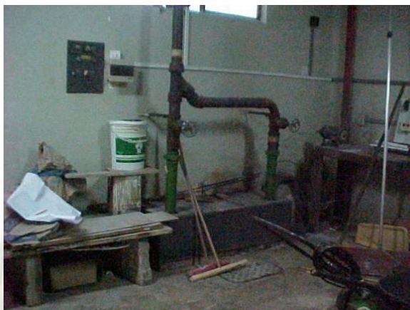
Poço água servida – subsolo.
