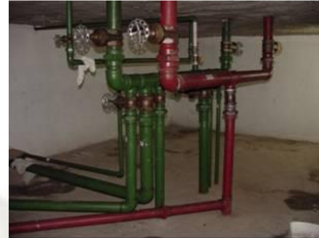
Barrilete sem shaf visitável descendo pela laje.
