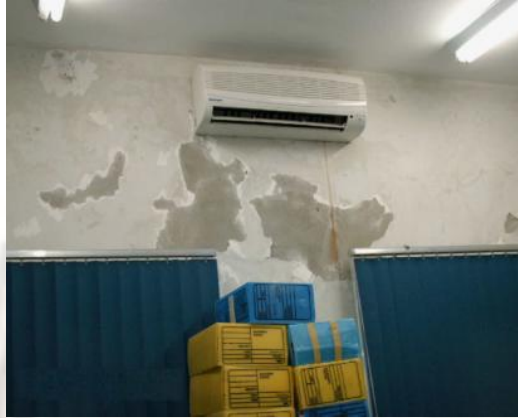
Infiltrações generalizadas
