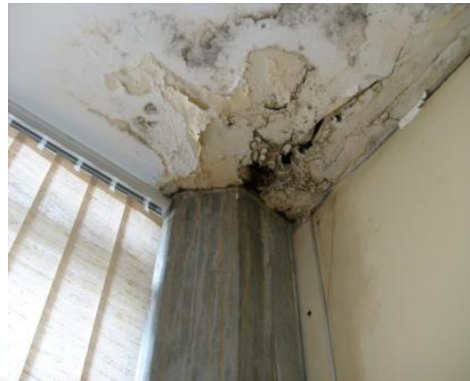
Infiltrações graves nas lajes
