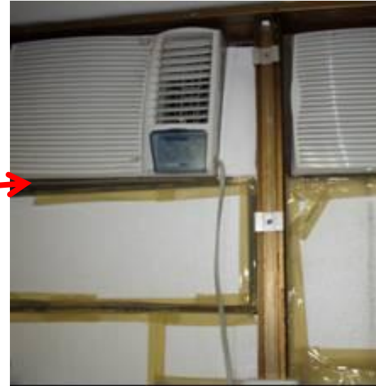
Detalhe do isolamento térmico e dos ACJ's
