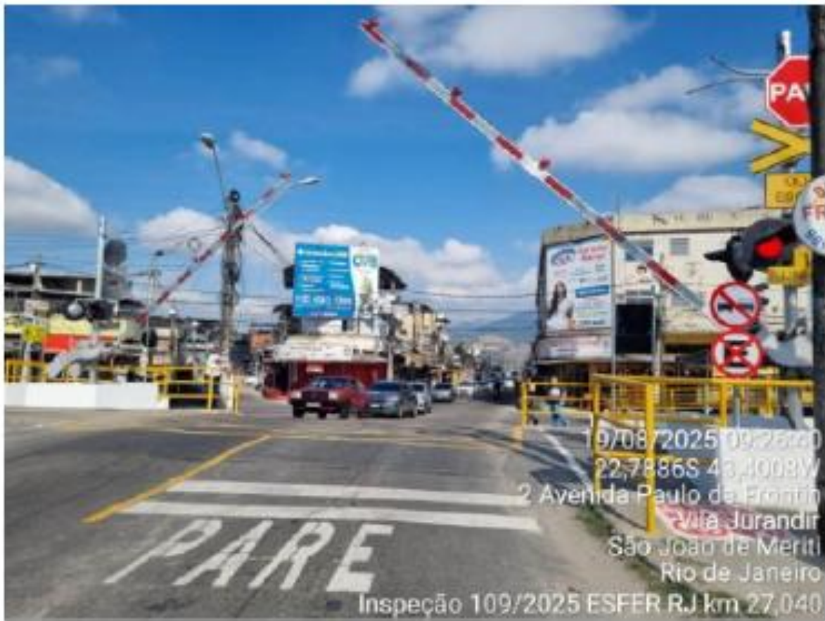
Foto da Inspeção ANTT em 19/08/2025 na mesma visada do Google em 2024 demonstrando recuperação e automação da PN.
