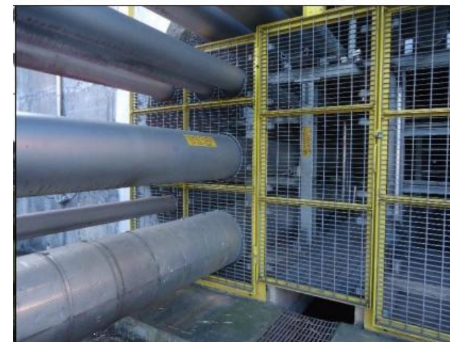
Fig. 06 – Barreira física para acesso da parte de travessia abaixo do viaduto (túnel) do lado da REPAR.
