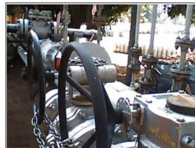
Fig. 09 – Sistema de válvulas de bloqueio dos dutos de GLP.
