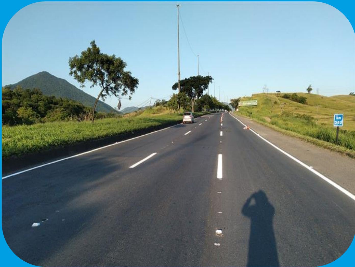
Pavimentação, pintura e implantação de tachas
