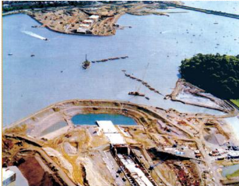
Vista Geral de um Canteiro de Obras Fonte: Tribune, 1999)
