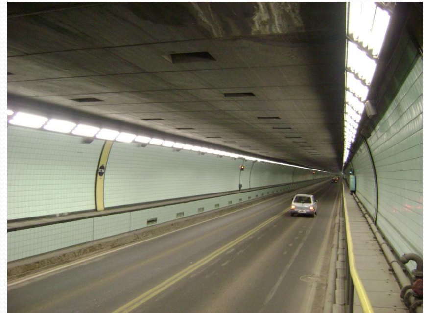
Vistas do Interior do Túnel
