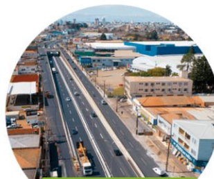
Viaduto BR 373 (Av. Souza Naves / Ponta Grossa) km 173
