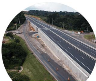
Interseção PR 151 (Piraí do Sul) - km 256
